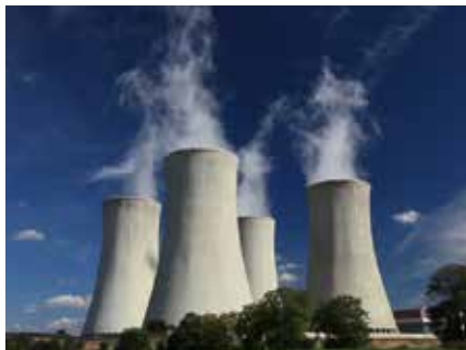
Figura 4 – Torres de Refrigeração no formato de um hiperboloide.
