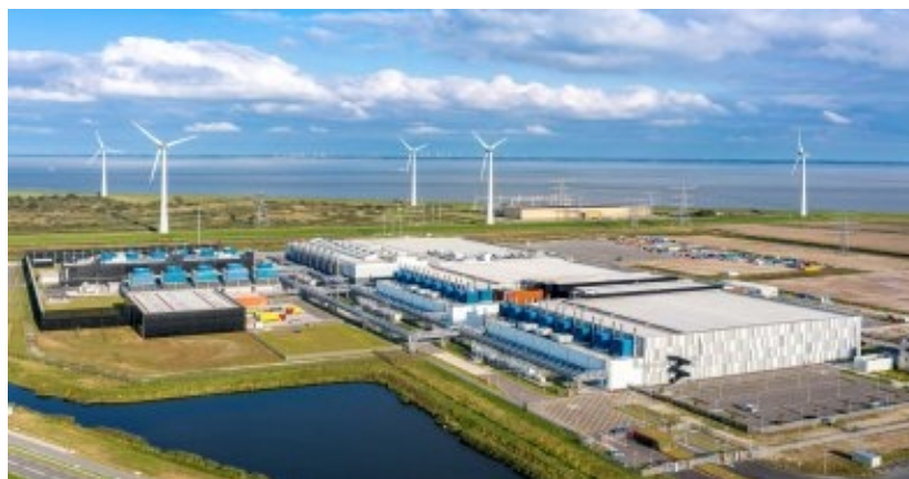
Figura 2: Foto externa do data center da Google.
