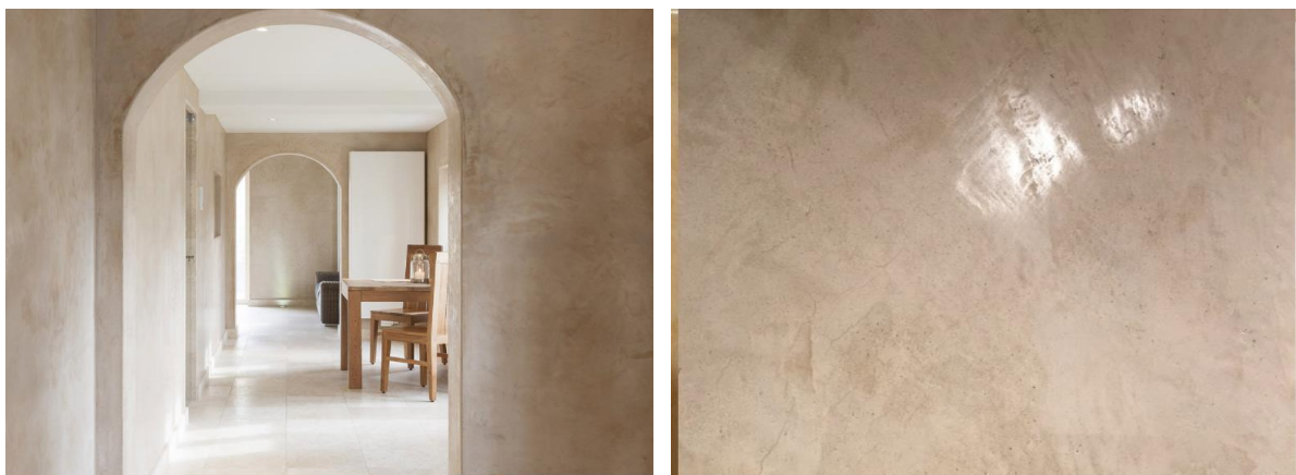
Figura 8 Aplicação Tadelakt – Aplicação feita no Interior das residências marroquinas
