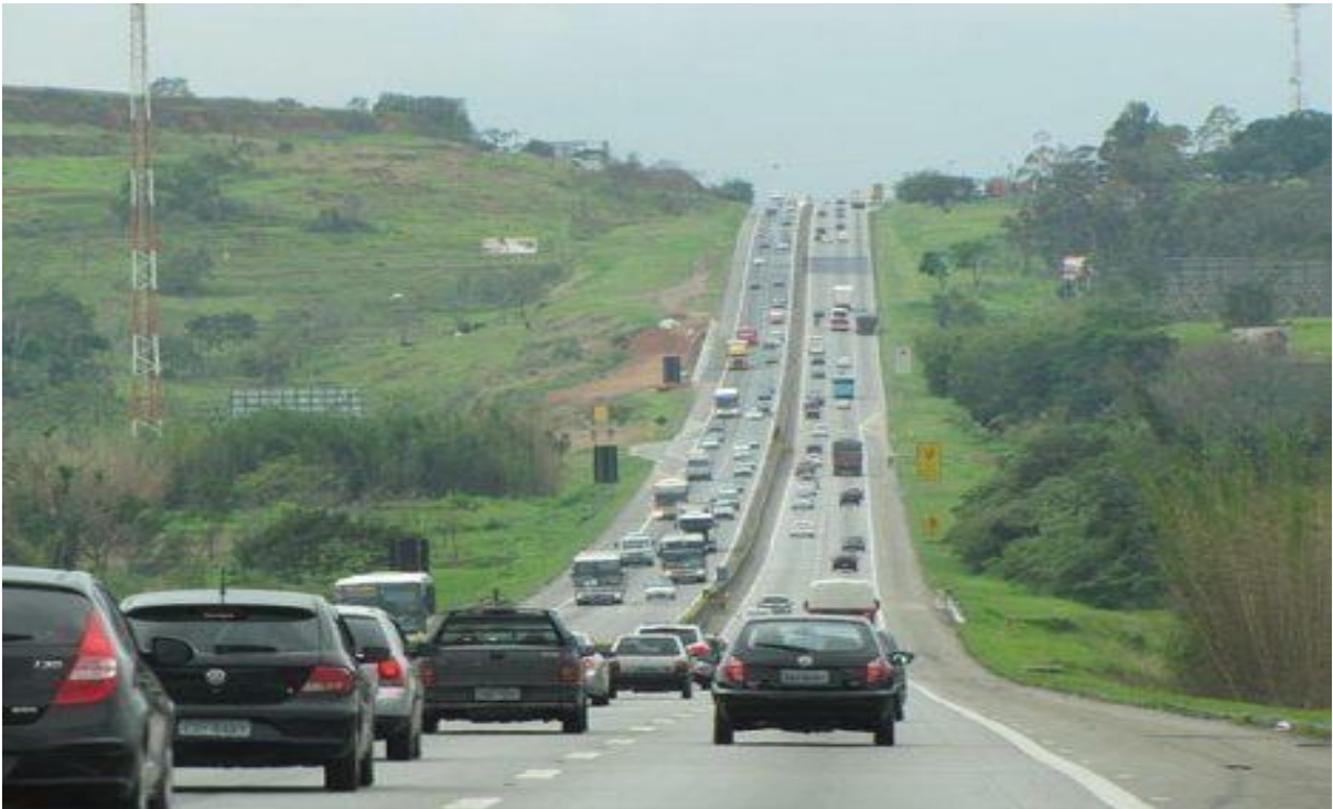
Figura 04: Trecho da Rodovia Presidente Dutra (BR-116),
