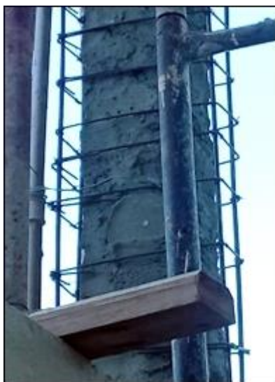
Figura 12: Aplicação de reforço na estrutura do pilar.
