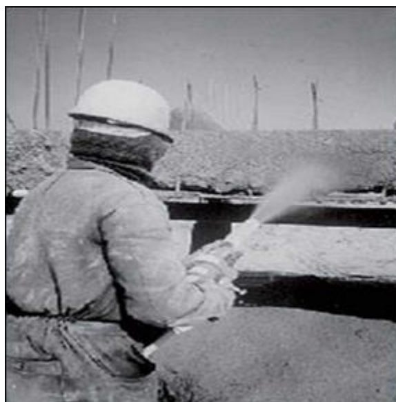
Figura 4: Concreto projetado por via úmida.
