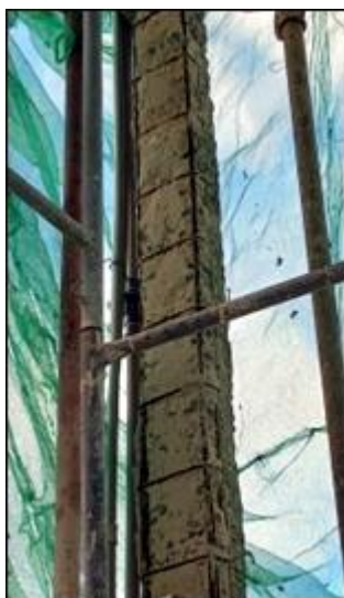
Figura 10: Camada de concreto removida.
