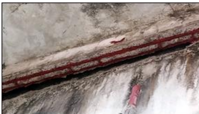
Figura 15: Armadura da viga após a aplicação do produto.
