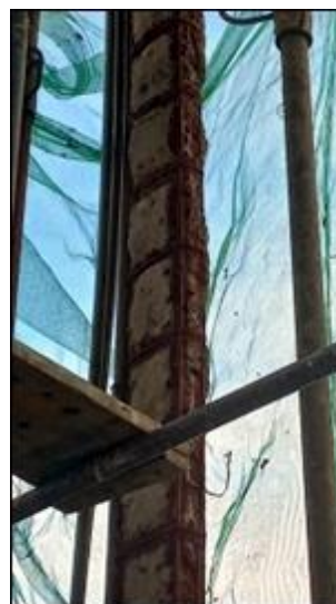
Figura 11: Armadura após a aplicação.
