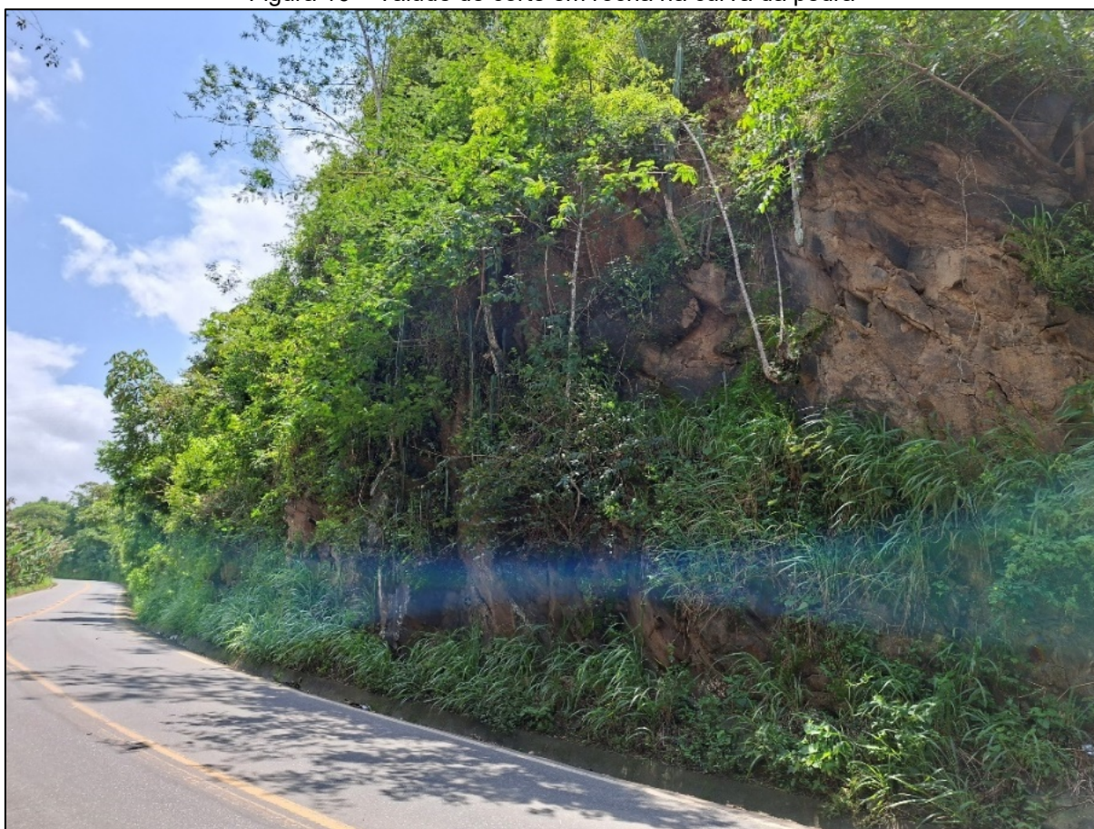
Figura 16 – Talude de corte em rocha na curva da pedra
