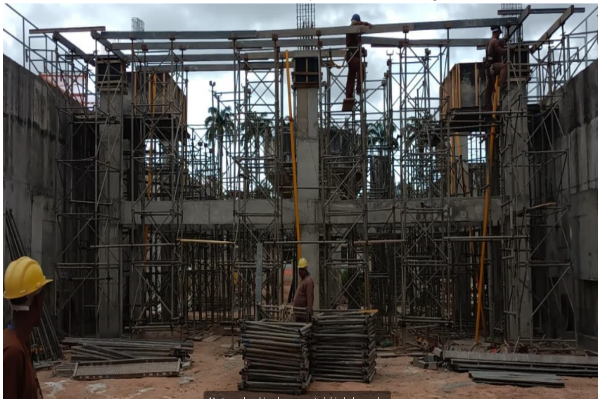
Figura 3 – Escoramento metálico do projeto de escoramento para concretagem da laje de fundo do desarenador, elemento estrutural da estação de tratamento de esgoto
