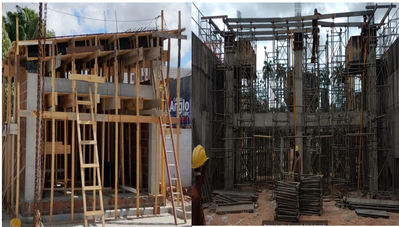
Figura 9 – Montagem do sistema de escoramento metálico e de madeira na ETE, Cordeiro
