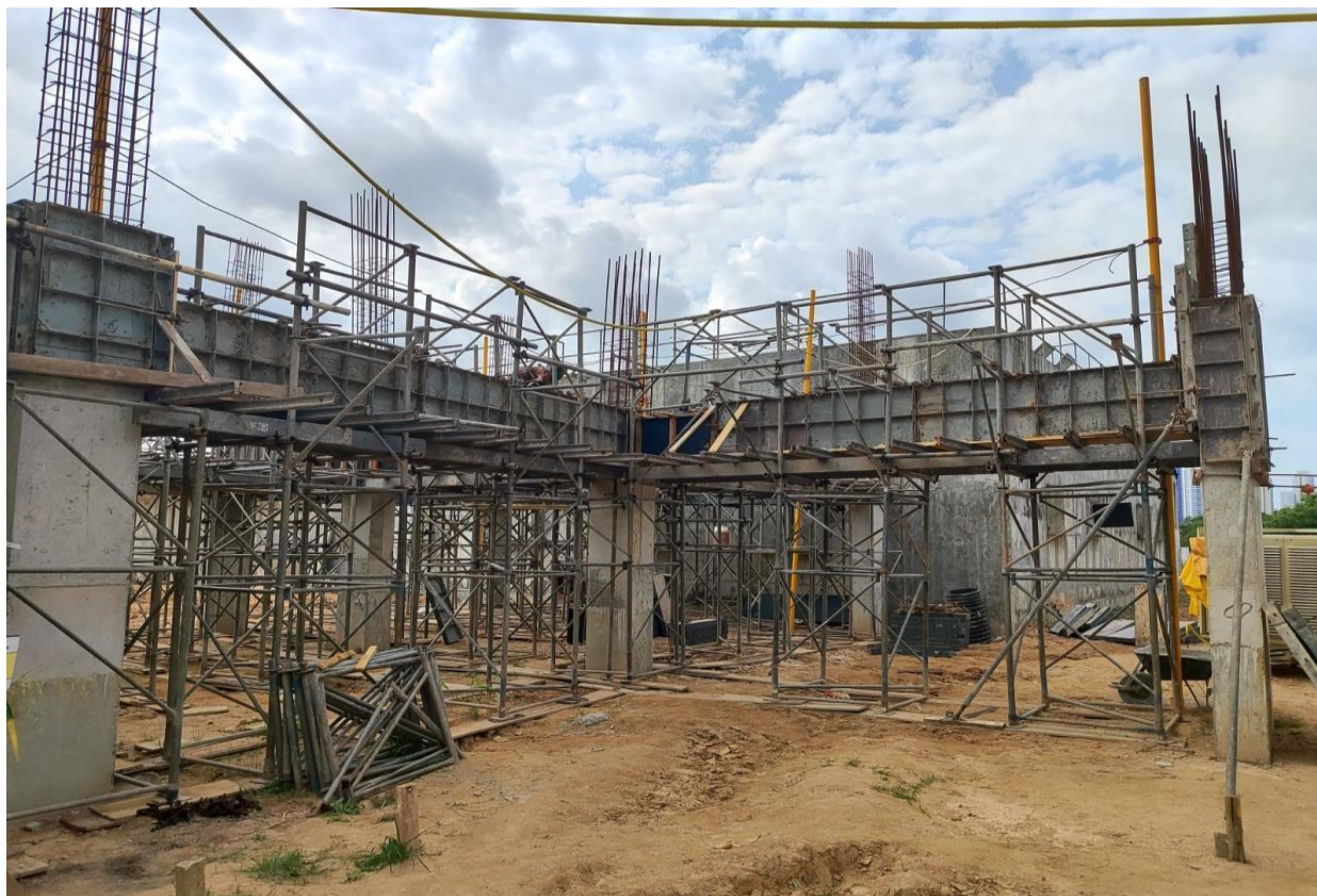
Figura 2 – Escoramento metálico para concretagem de laje de fundo do desarenador elemento estrutural da estação de tratamento de esgoto
