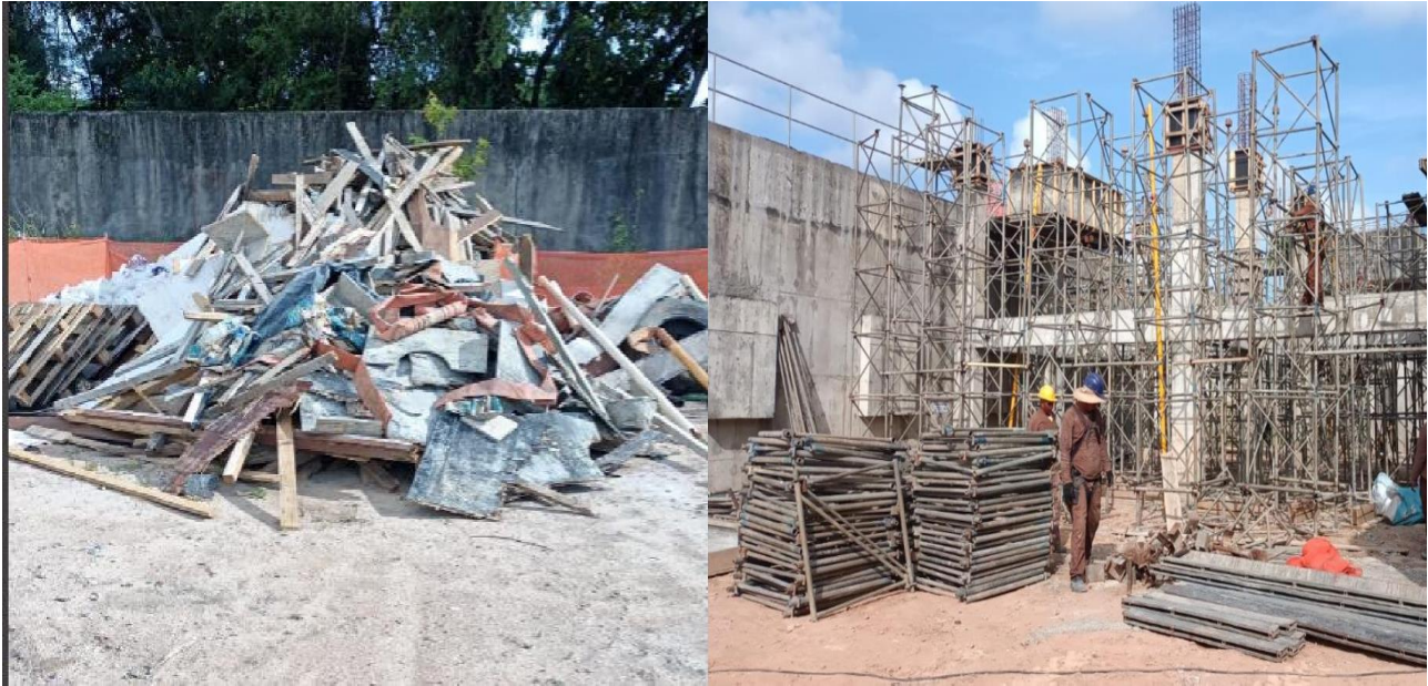
Figura 10 – Avaliação comparativa dos resíduos provenientes de escoramentos de madeira e metálicos na Ete Cordeiro
