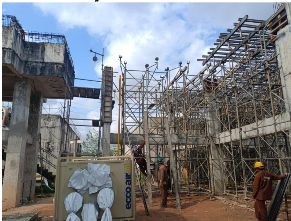
Figura 1- Escoramento metálico S5
