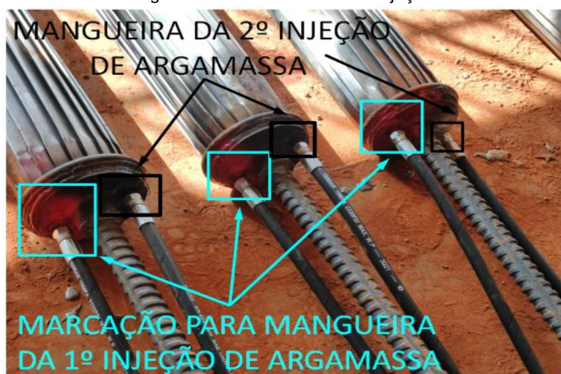
Figura 4 – Detalhamento da injeção.
