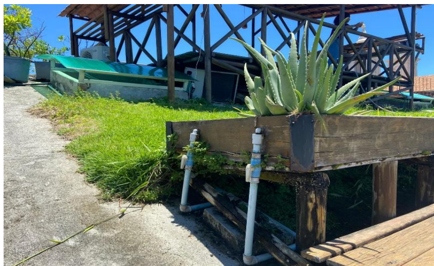
Figura 03- Tubos instalados para utilização do sistema
