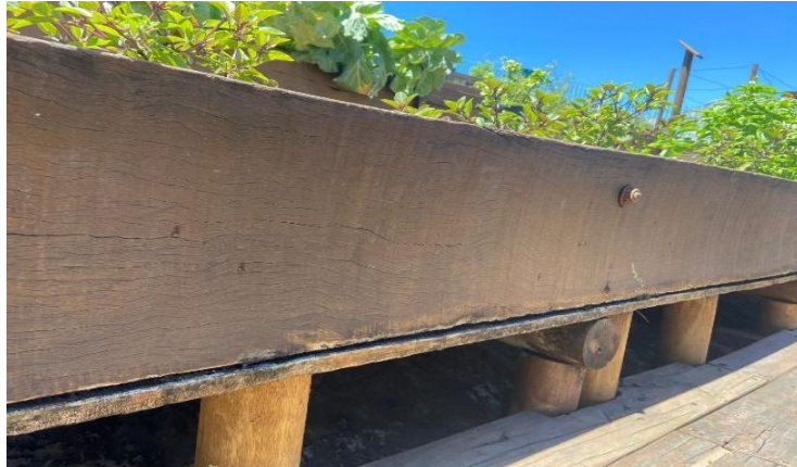
Figura 07- Estrutura roliça utilizada no telhado
