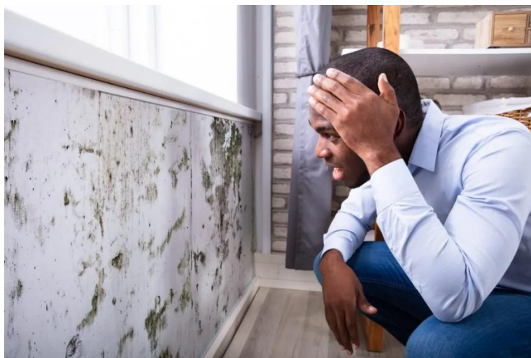
Figura 4 - Infiltração por capilaridade.
