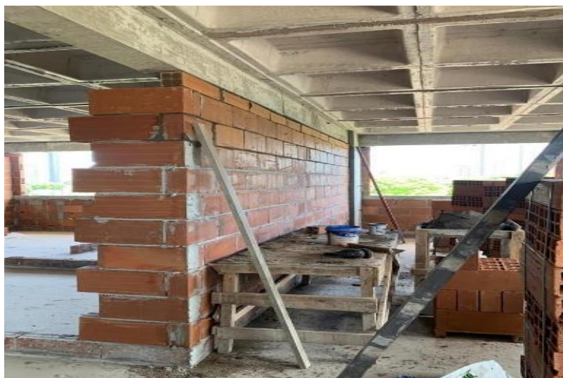
Figura 7 – Alvenaria já preenchida com a vermiculita
