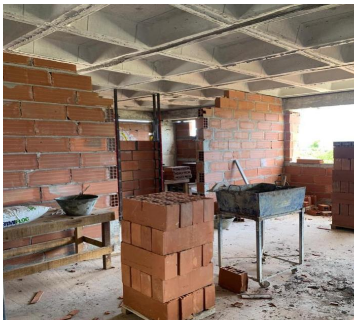
Figura 6 – levantamento das paredes
