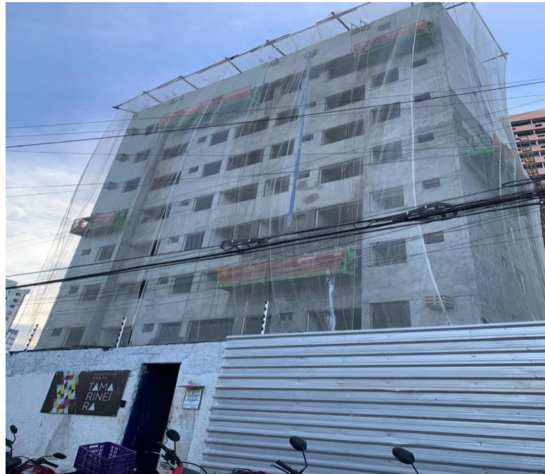
Figura 10 – obra em andamento
