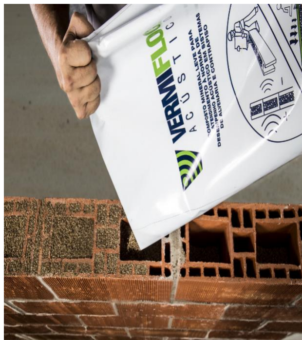
Figura 4 - aplicação da vermiculita
