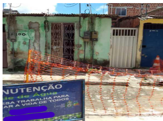
FIGURA 18 - RECOMPOSIÇÃO DEVIDAMENTE SINALIZADA
