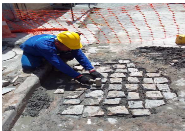
FIGURA 17 - RECOMPOSIÇÃO DE PAVIMENTO RÍGIDO
