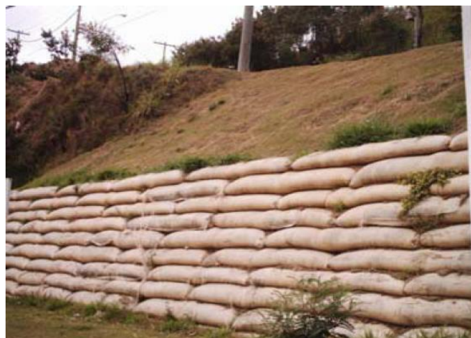
Figura 5 - Muro Saco-Solo Cimento
