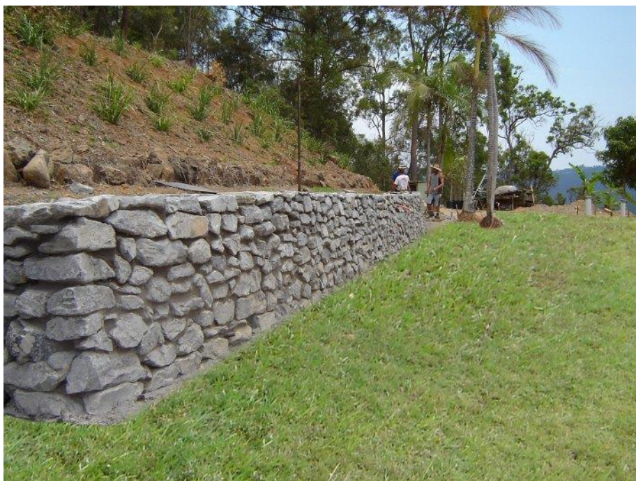
Figura 1 – Muro de Alvenaria de Pedra
