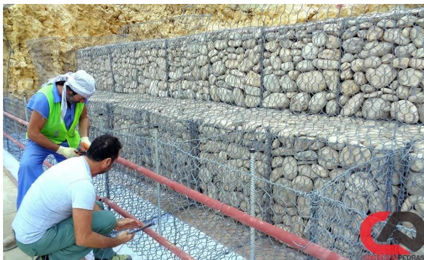
Figura 6 - Muro de Gabião.
