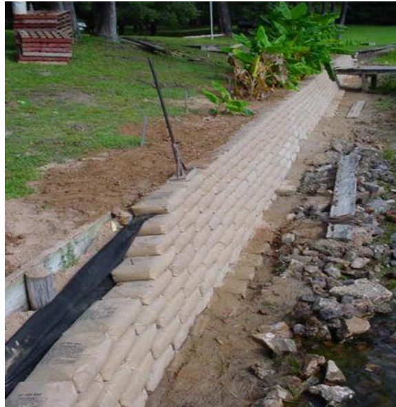
Figura 4 – Muro Saco-Solo Cimento sendo construído
