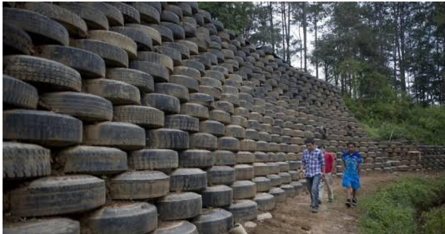
Figura 2 – Uso de Pneus em Muro de Contenção.
