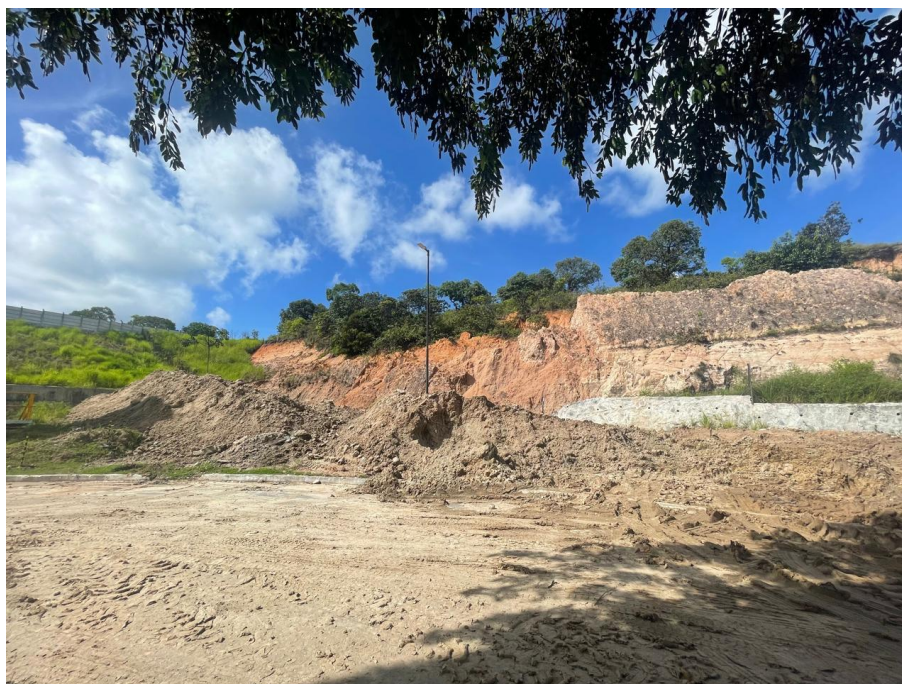
Figura 1 - Obra de contenção de taludes – material para descarte
