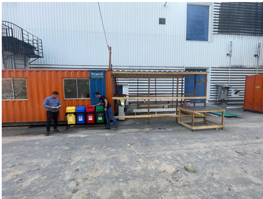
Figura 2 - Instalação de coletor seletivo no canteiro de obras - Visita 01
