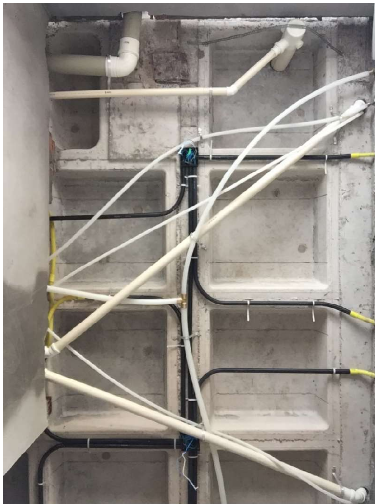
Figura 20 - Tubulação de água fria e quente, da cozinha e em PEX executada.
