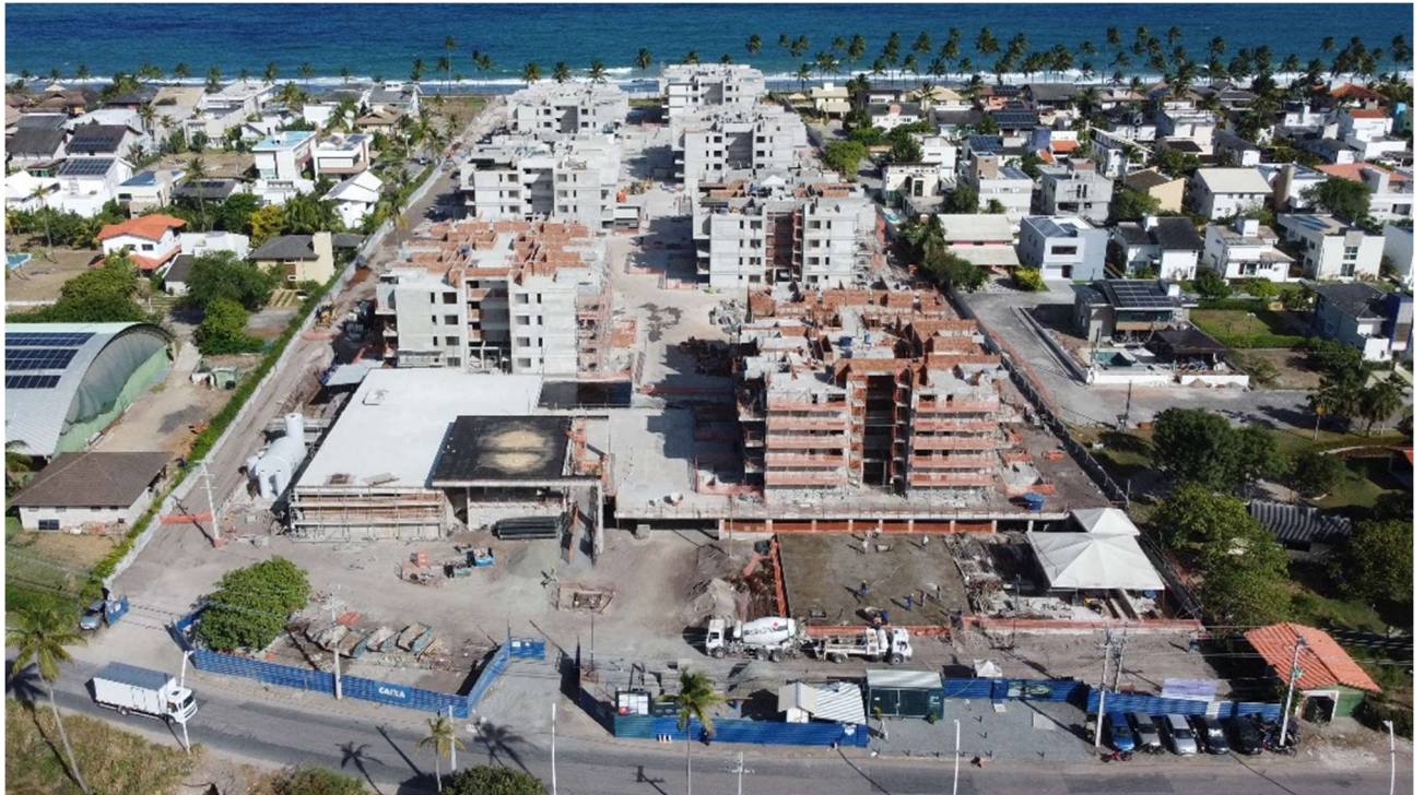
Figura 13 – OBRA ECO CAIS VISTA DE CIMA.
