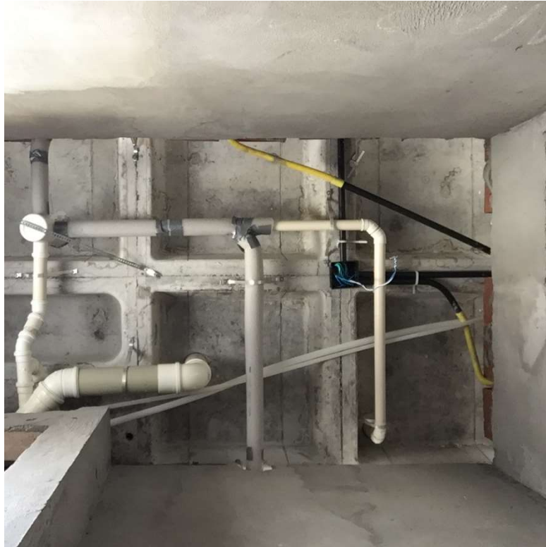
Figura 21 - Tubulação de água fria e quente, do banheiro social, em PEX executada.
