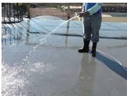
FIGURA 6 – CURA DO CONCRETO.
