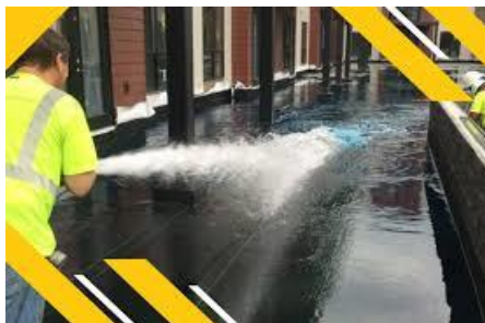
FIGURA 5 – TESTE DE IMPERMEABILIZAÇÃO.
