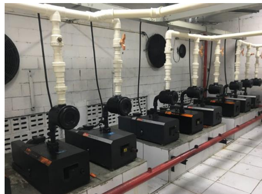
Figura 7: Central de Vácuo
