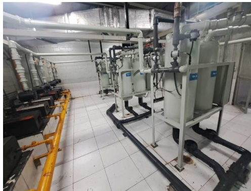
Figura 6: Central de Vácuo
