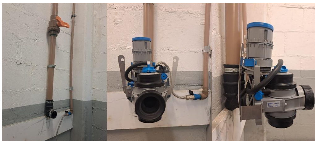
Figura 14: Vaso sanitário e partes principais e painel traseiro
