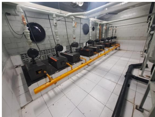
Figura 7: Central de Vácuo
