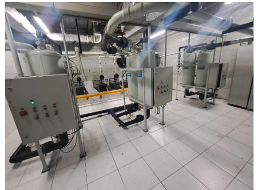
Figura 6: Central de Vácuo
