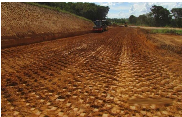
Figura 3 - Compactação do subleito
