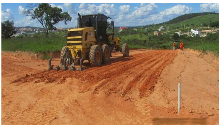
Figura 1 - Escarificação do subleito para tratamento e reforço
