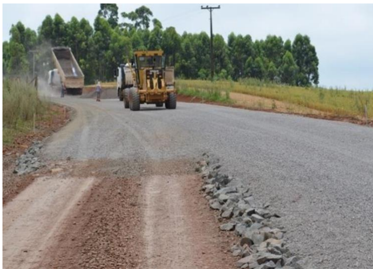
Figura 4 - Camada base e sub-base
