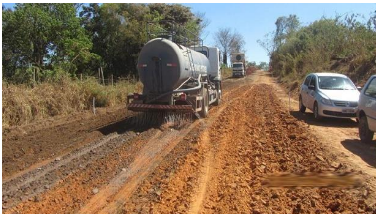
Figura 2 - Umidificação do subleito para execução dos serviços
