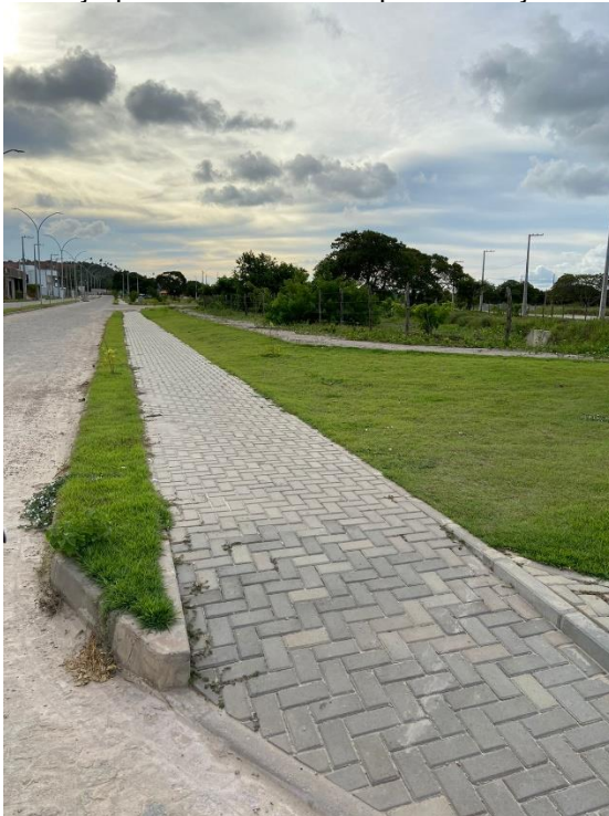
Figura 19 – Praça pronta com área de pavimentação e área verde.
