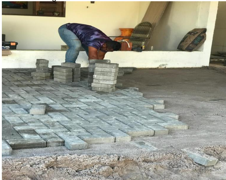
Figura 18 – Assentamento dos blocos.
