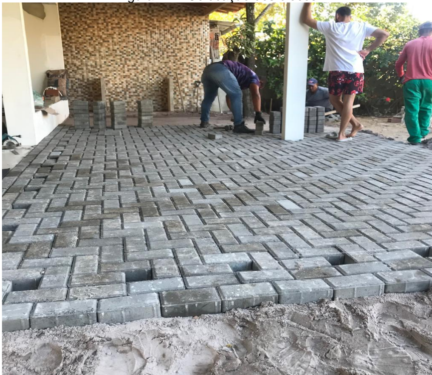
Figura 17 – Colocação dos blocos.
