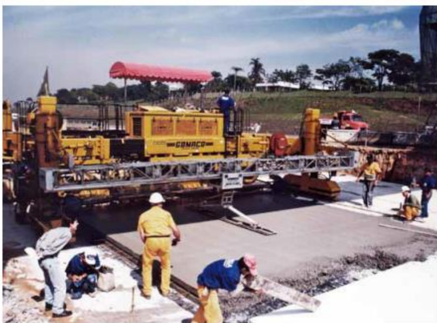
Figura 11 – Vibroacabadora na construção do pavimento de concreto na Nova Dutra
