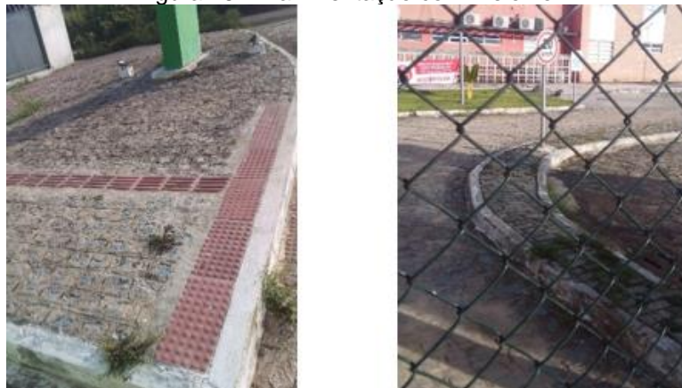
Figura 25 – Pavimentação com meio fio.
