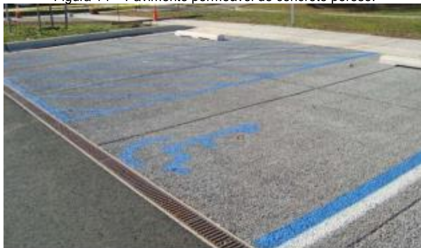
Figura 14 – Pavimento permeável de concreto poroso.
