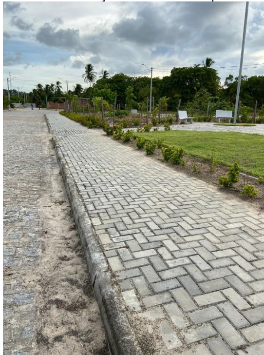
Figura 23 – Pavimentação feita com vista para o meio-fio
