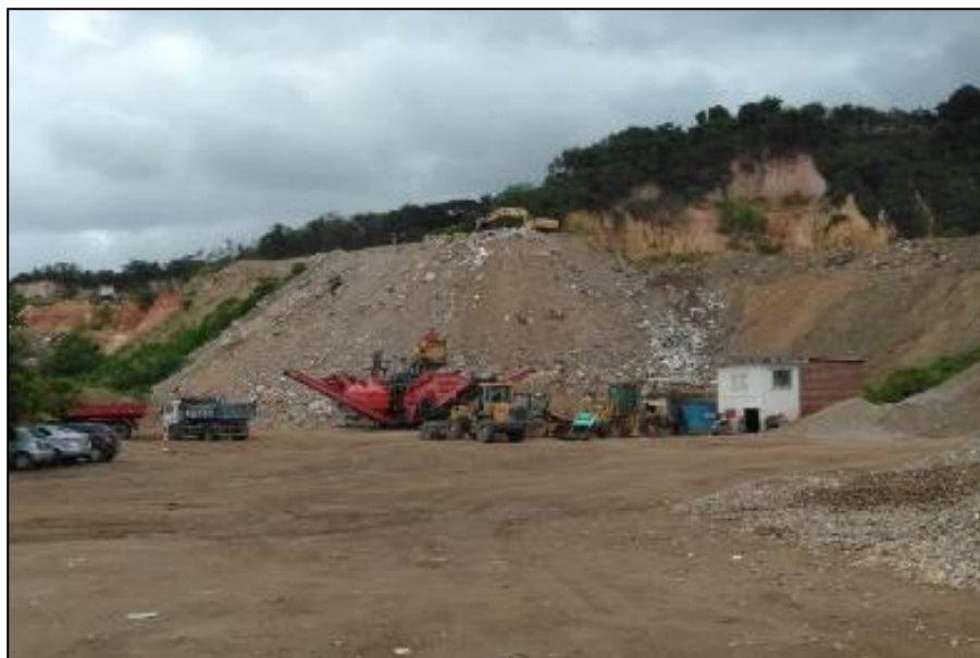
Figura 12. Área de descarte dos RCD's recebido
