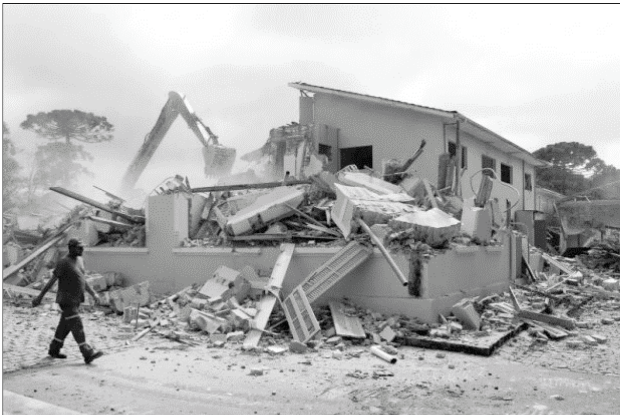
Figura 2: Demolição indiferenciada do Hospital Bom Retiro em Curitiba/PR
