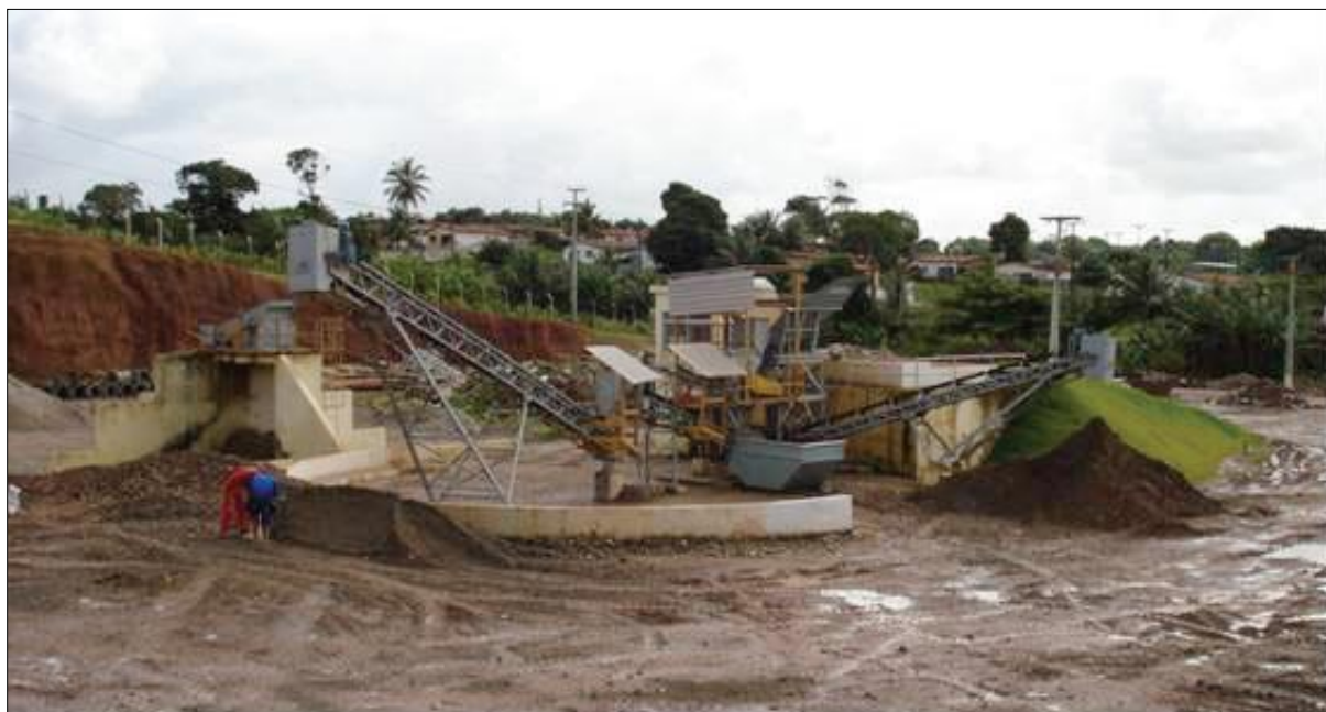
Figura 3. Usina de Reciclagem de RCD na cidade de Joao Pessoa
