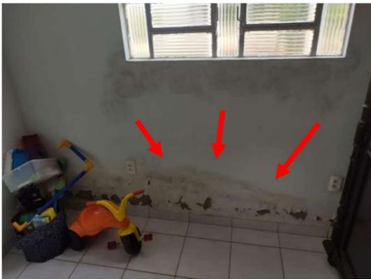
**Figura 4:** Tubulação de água danificada parede do quarto/banheiro
