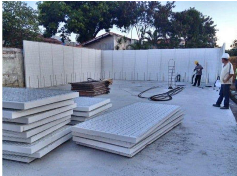
Figura 11: Painéis monolíticos aplicados no radier.
