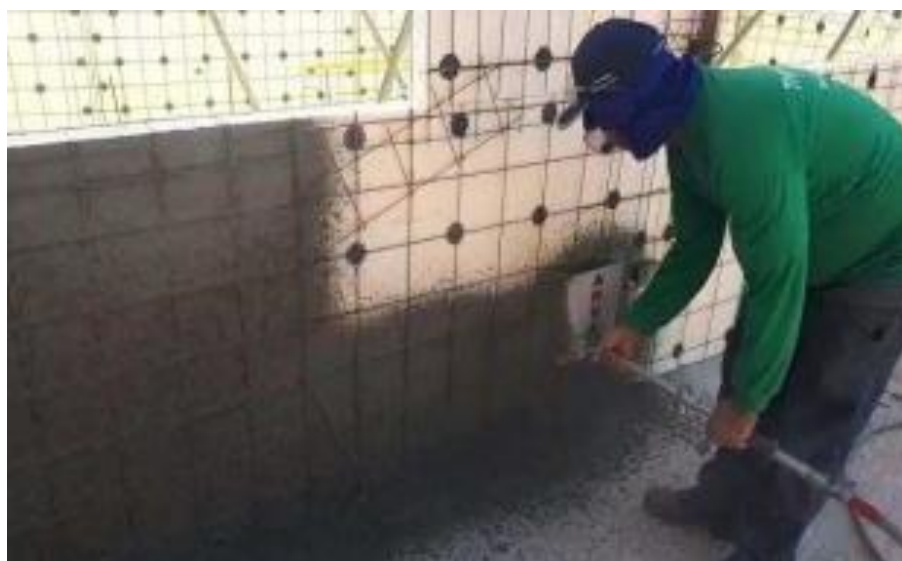
Figura 12: Revestimento do EPS
