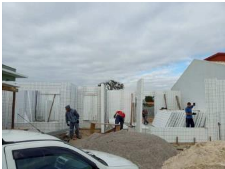
Figura 30: montagem dos painéis
