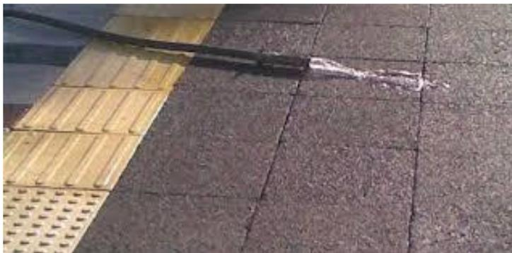
**Figura 20:** Pavimento com revestimento constituído por peças de concreto permeável sem intertravamento.
