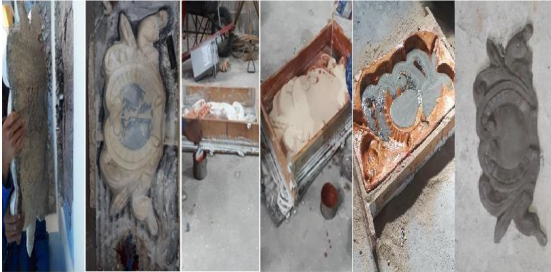
Figura 23. Restauração das molduras.
