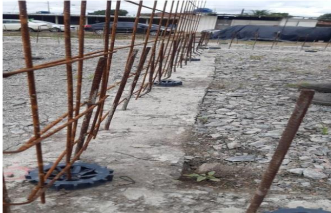
Figura 7 – Gabarito espaçador de fôrma
