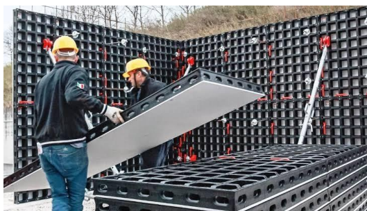
Figura 4 – Sistemas de fôrma plástica
