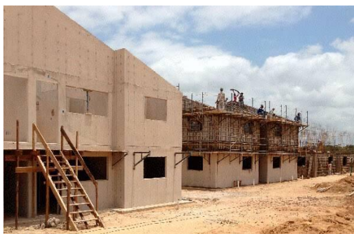
Figura 2 – Parede de concreto
