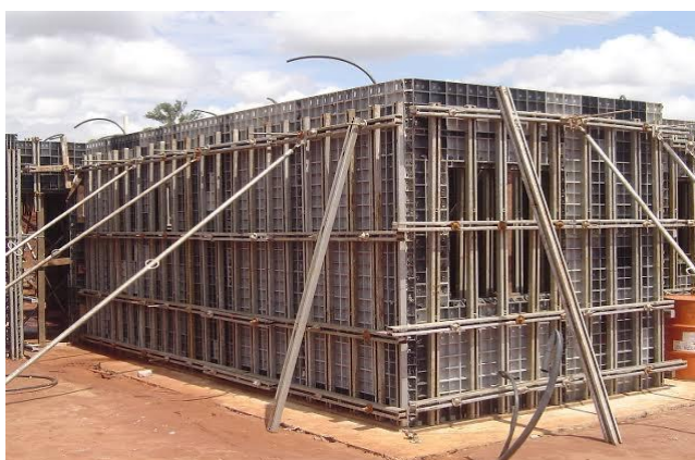
Figura 5 – Sistemas de fôrma mista
