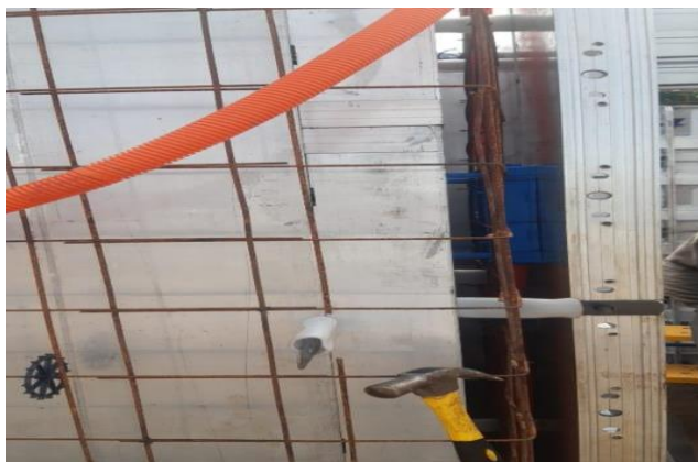
Figura 11- Camisinha para gravata metálica
