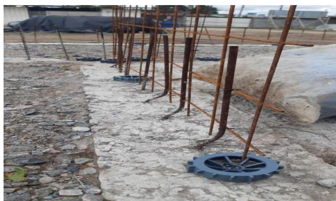
Figura 6 – Gabarito espaçador de fôrma
