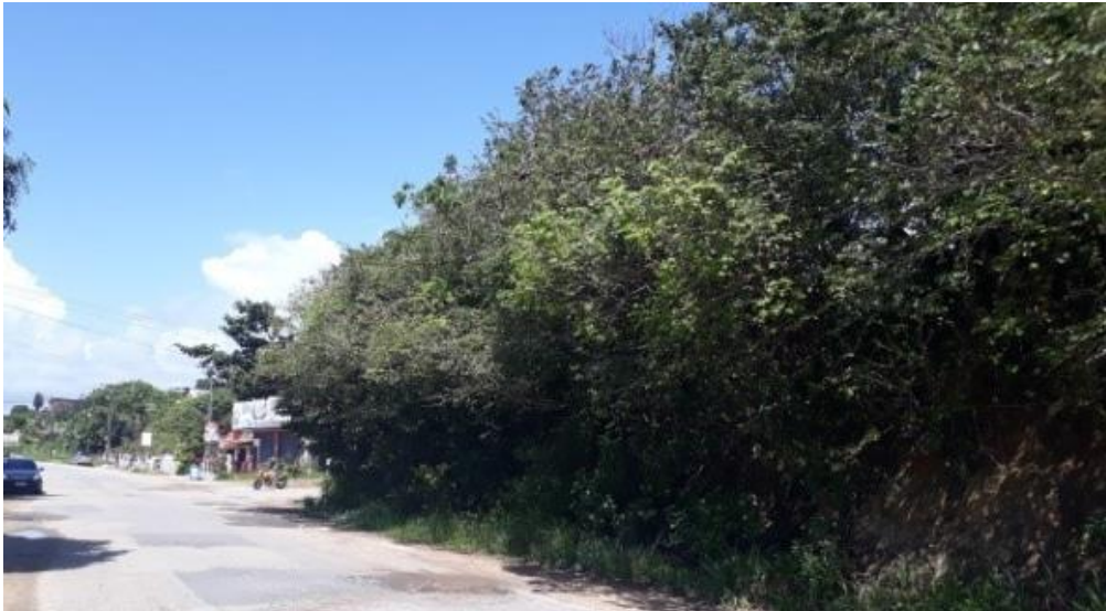
Figura H – Talude com aproximadamente 5 metros de altura
