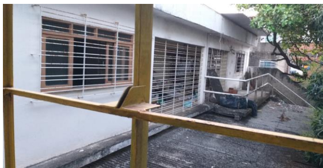
Figura 5 – Fachada do 1º andar da residência.
