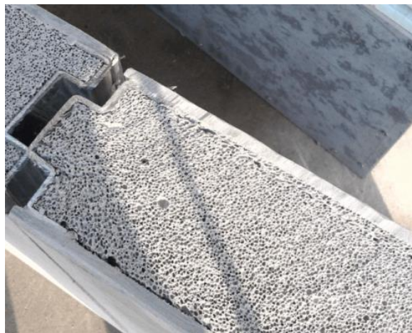
Figura 4: CCE usado como núcleo no painel estrutural, com placas cimentícia e encaixes metálicos
