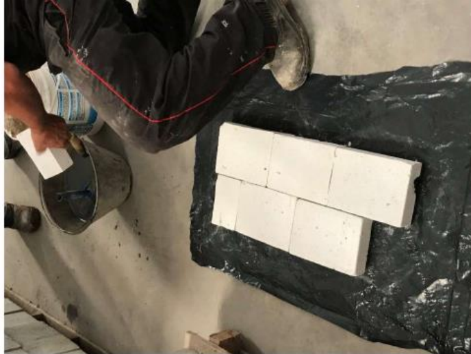
Figura 5: Início da aplicação da Argamassa de Assentamento Juntabloko do Grupo Inkor
