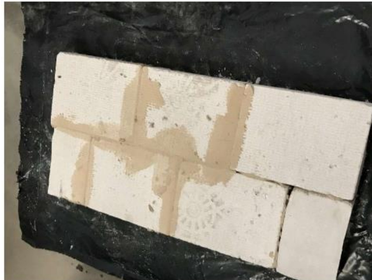
Figura 6: Aplicação da Argamassa de Assentamento Juntabloko do Grupo Inkor.
