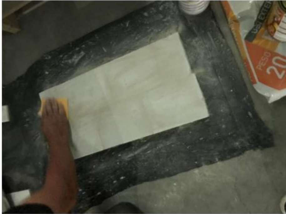
Figura 12: Lixamento da Alvenaria para aplicação da Massa Corrida.
