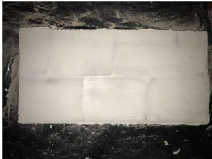
Figura 11: Aplicação da 1ª Demão da Massa Corrida Crilkor
