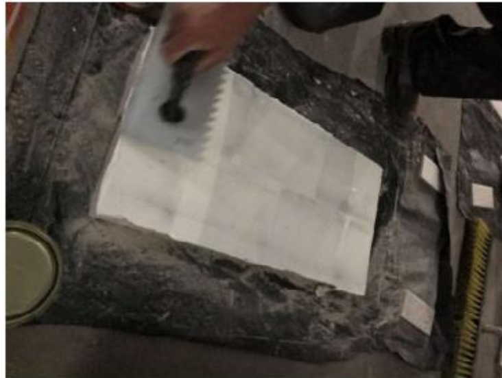
Figura 13: Aplicação da 1ª Demão da Massa Corrida Crikor.
