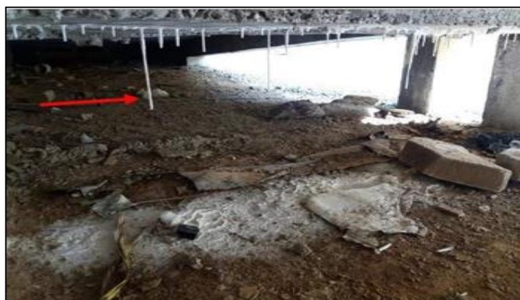
Figura 5 – Manifestação da eflorescência em formação de estalactite
