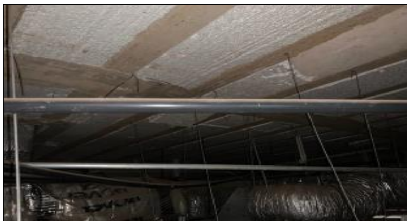
Figura 15 - Laje Fragilizada
