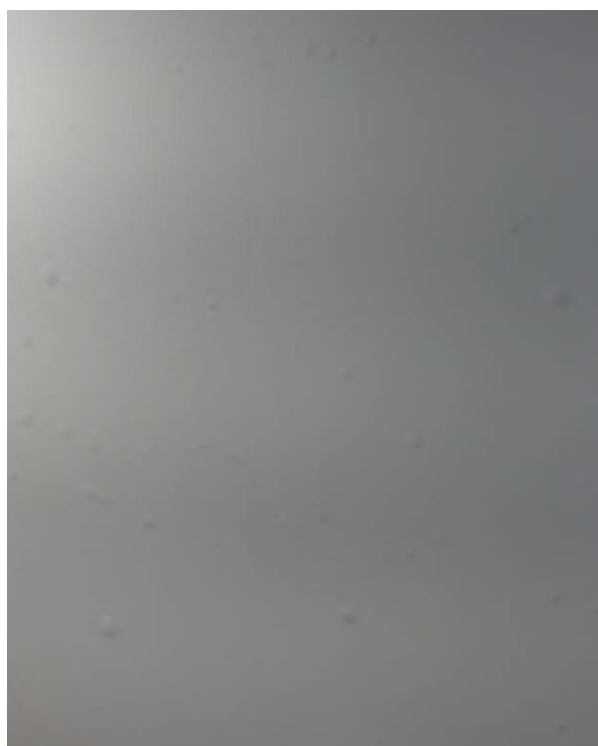
Figura 17 – Bolhas na pintura
