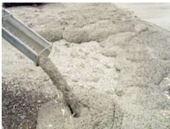
Figura 1 – Concretagem do piso do aeroporto de Bologna, Itália
