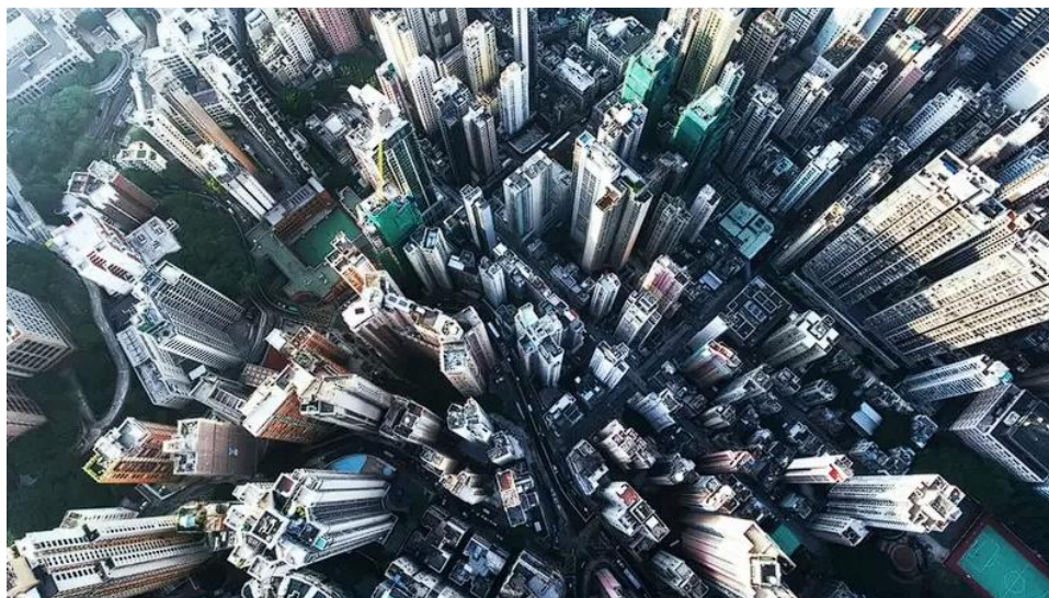
Figura 7 – Vista aérea da cidade de Hong Kong
