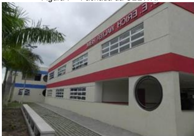
Figura 7 – Fachada da CEEWH.
