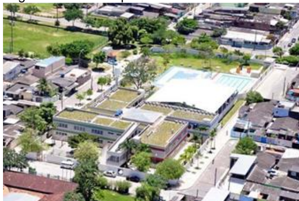
Figura 8 – Vista Superior do Teto Verde CEEWH.
