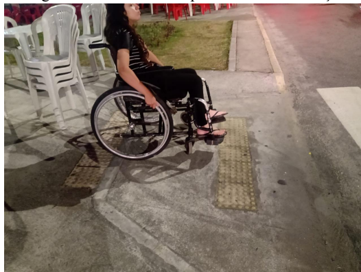
Imagem 3 — Rua com empreendimento na calçada
