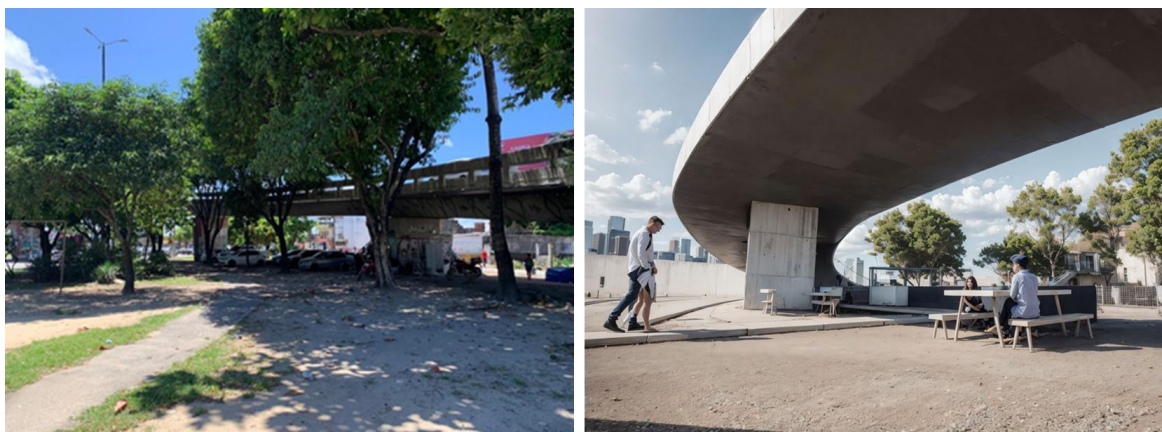
Figura 16 Imagens do projeto de intervenção, à esquerda o antes, à direita o depois.
