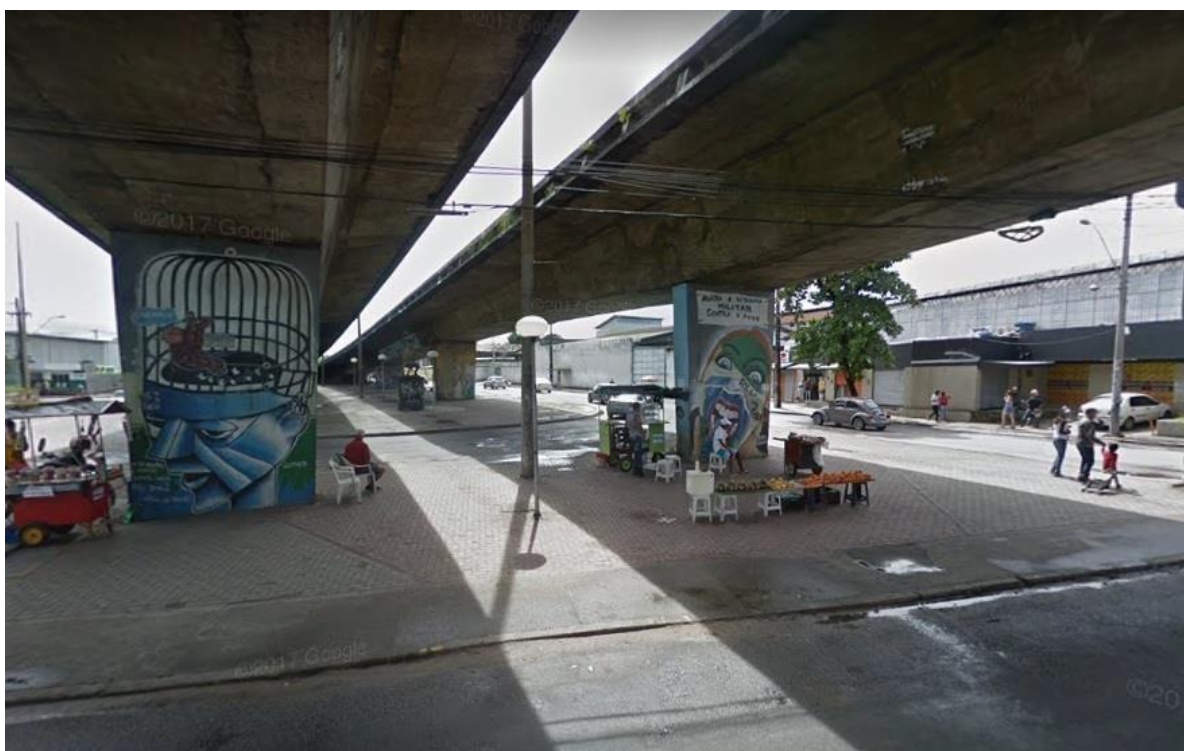
Figura 2 Viaduto da Caxangá.
