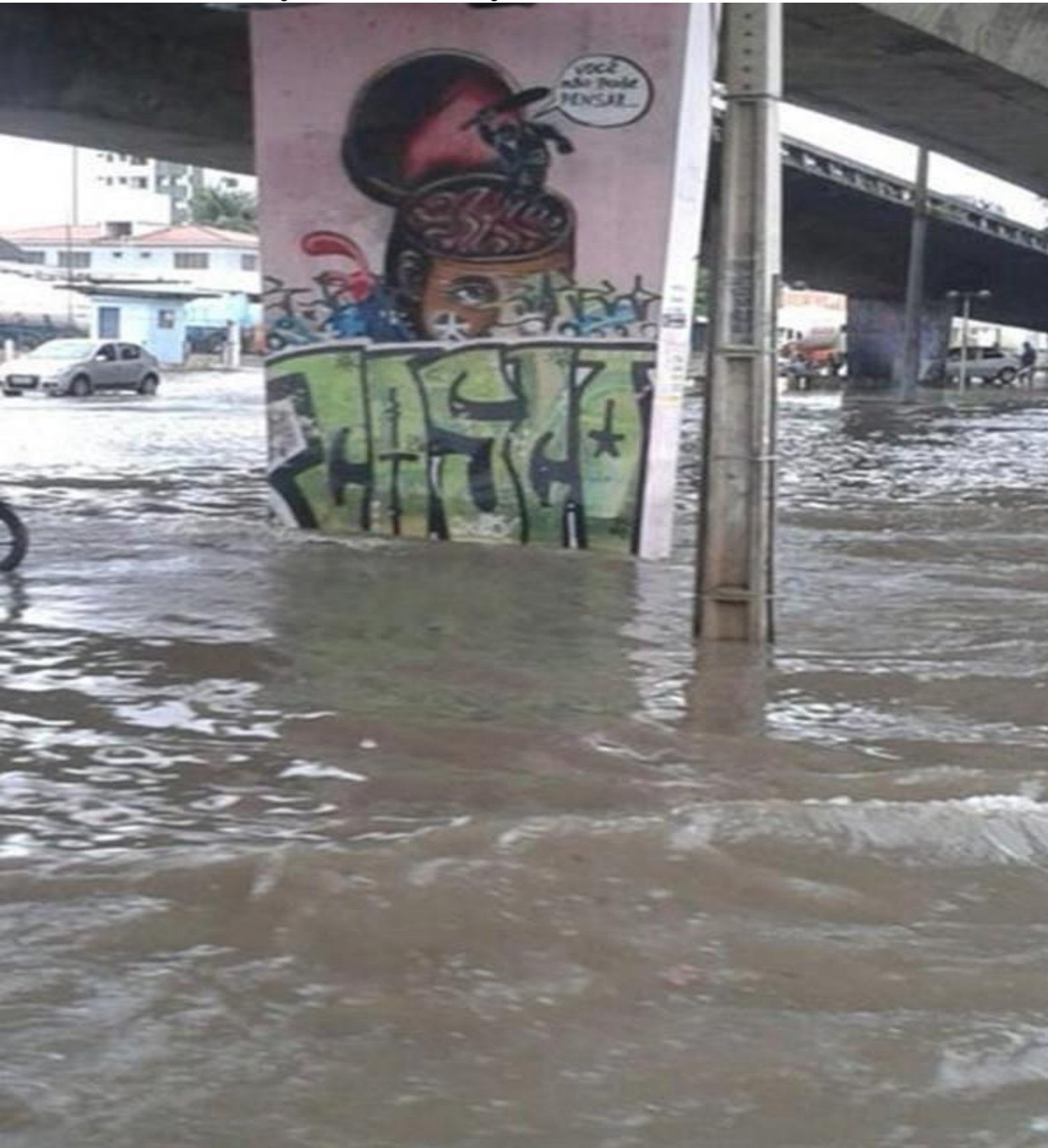
Figura 23. Viaduto da Caxangá em dias de chuva. Fonte. JC Pe, Recife 2023
