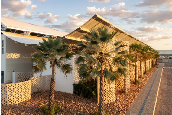
Figura 16 - Fachada hospital unileão
