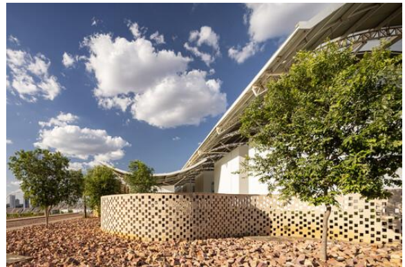
Figura 17 - Fachada hospital unileão
