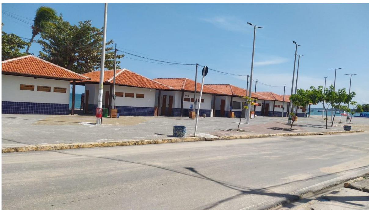
Imagem 32 – Calçada de Ponta de Pedras Fonte: Autoria Própria
