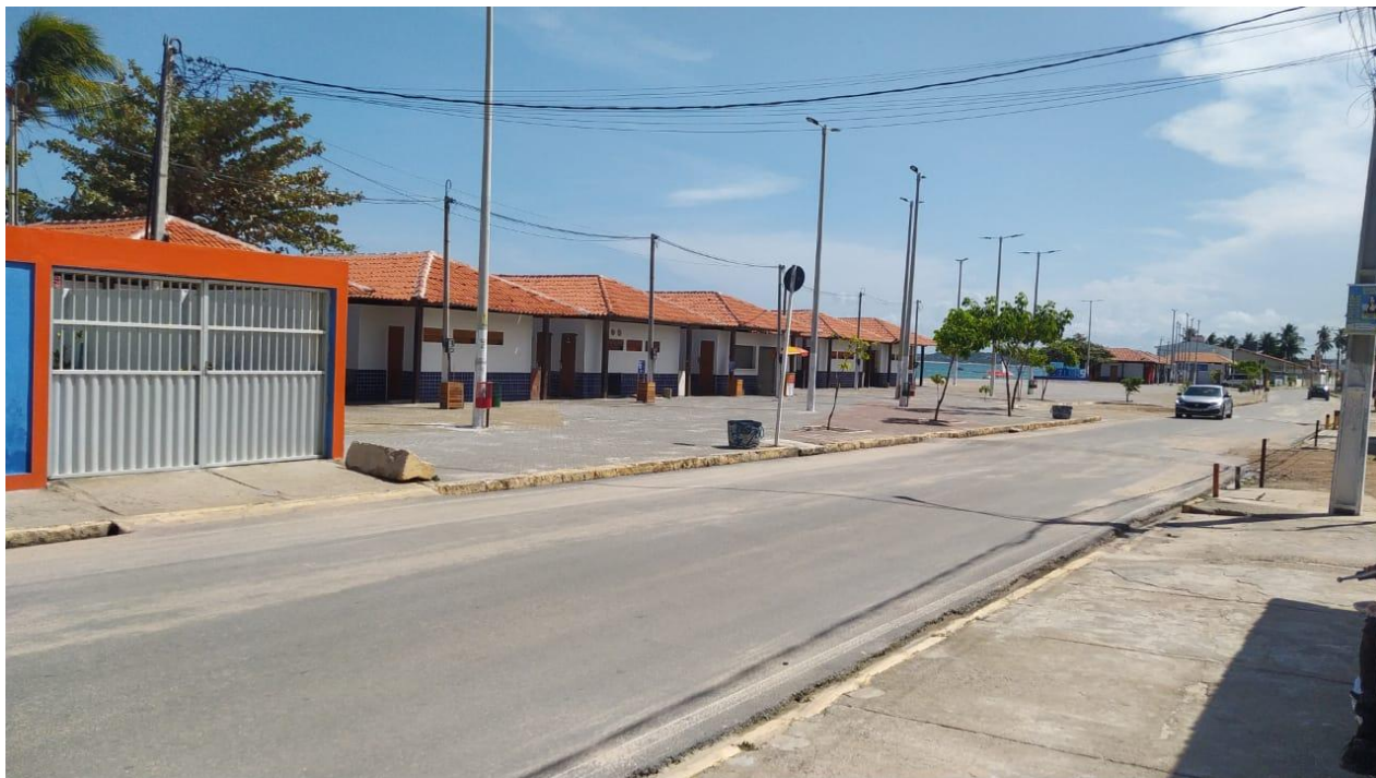
Imagem 31 – Calçada de Ponta de Pedras Fonte: Autoria Própria
