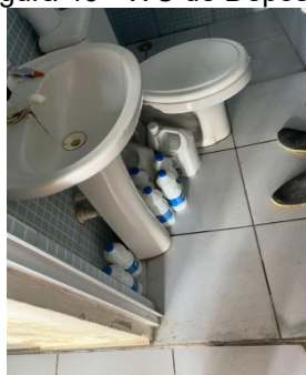
Figura 46 - WC de Depósito
