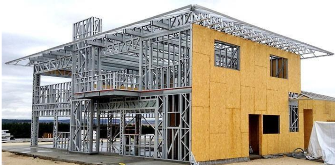
Figura 11: Construção em Stel Frame
