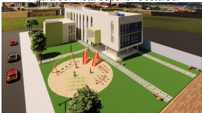
Figura 36: Vista Superior Oeste/Sul
