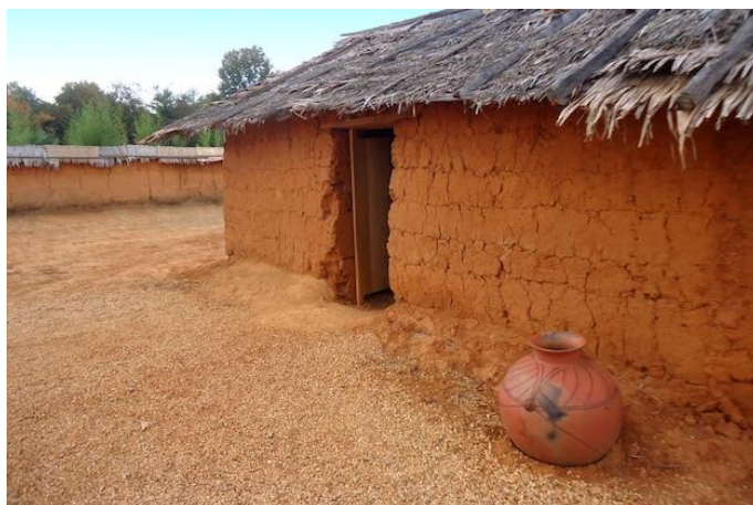
Figura 25- Casa de Taipa.
