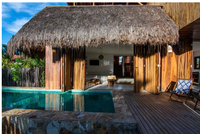
Figura 66- Telhado coberto com palha de piaçava.
