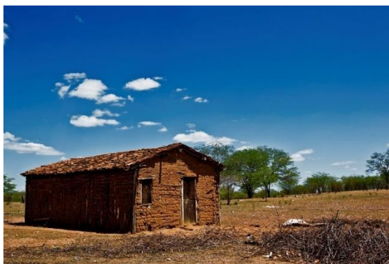
Figura 28- Casa de Taipa.
