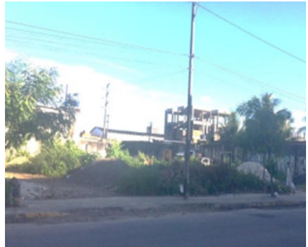
Figura 15: Foto em perspectiva do terreno
