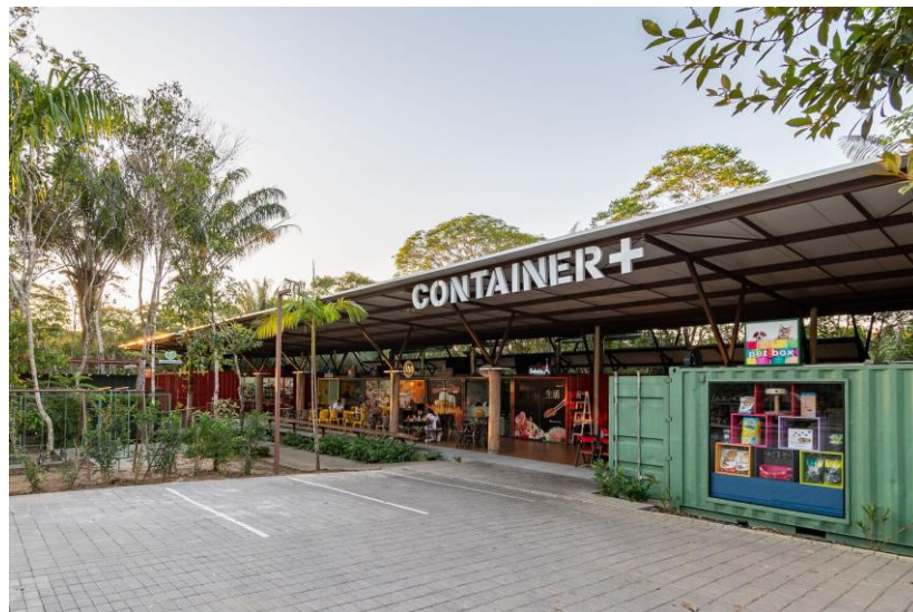
Figura 3 - Fachada Do Centro Comercial Container +
