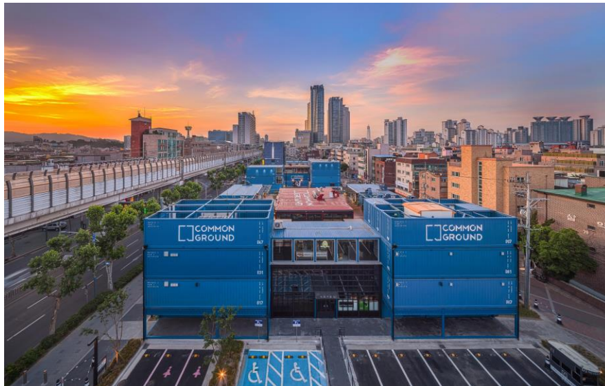
Figura 8 - Conexão entre os dois prédios
