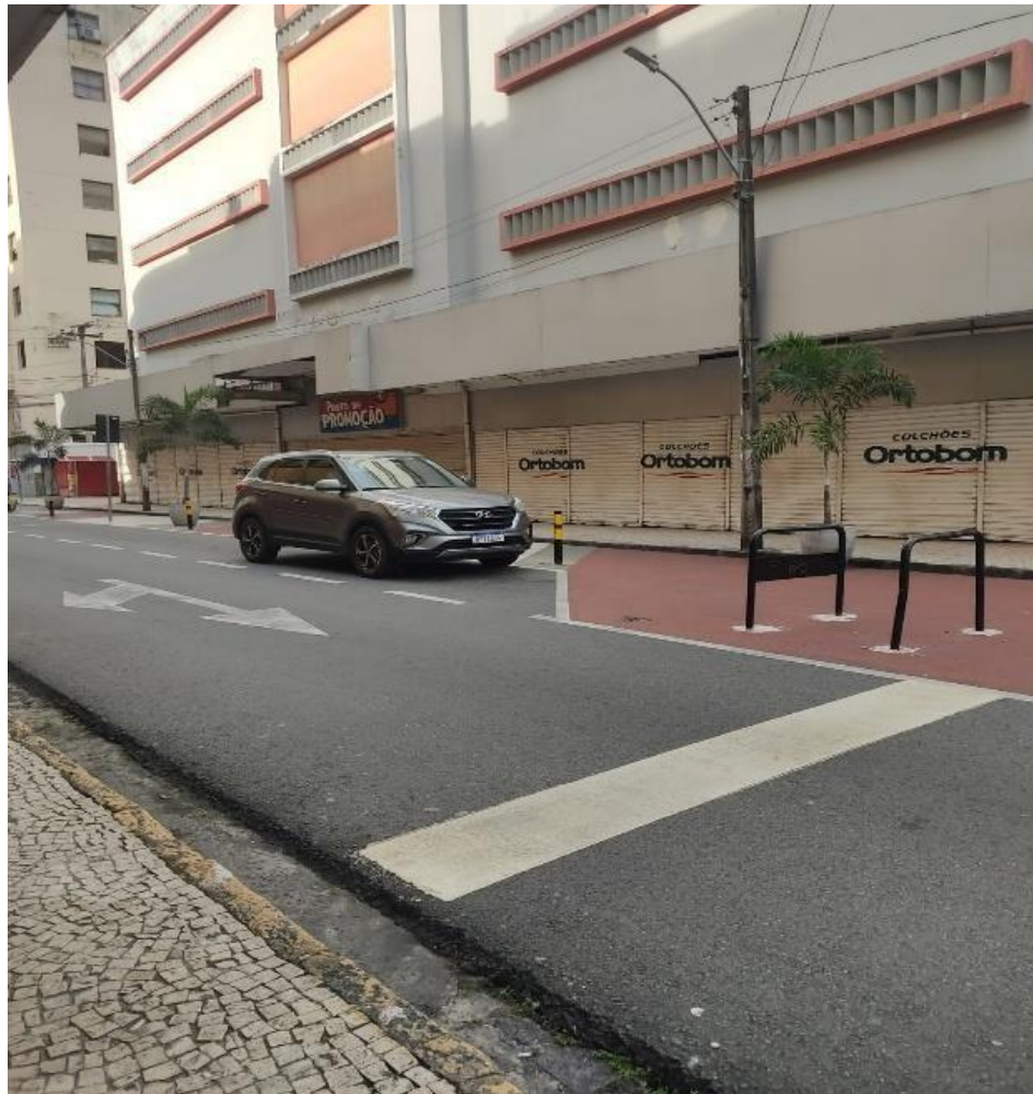
FIGURA 10: Rua da Palma após a intervenção
