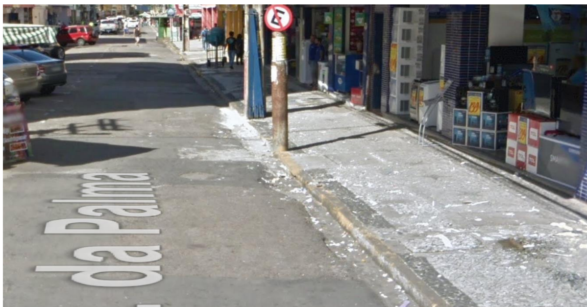
FIGURA 07: Rua da Palma antes da intervenção.
