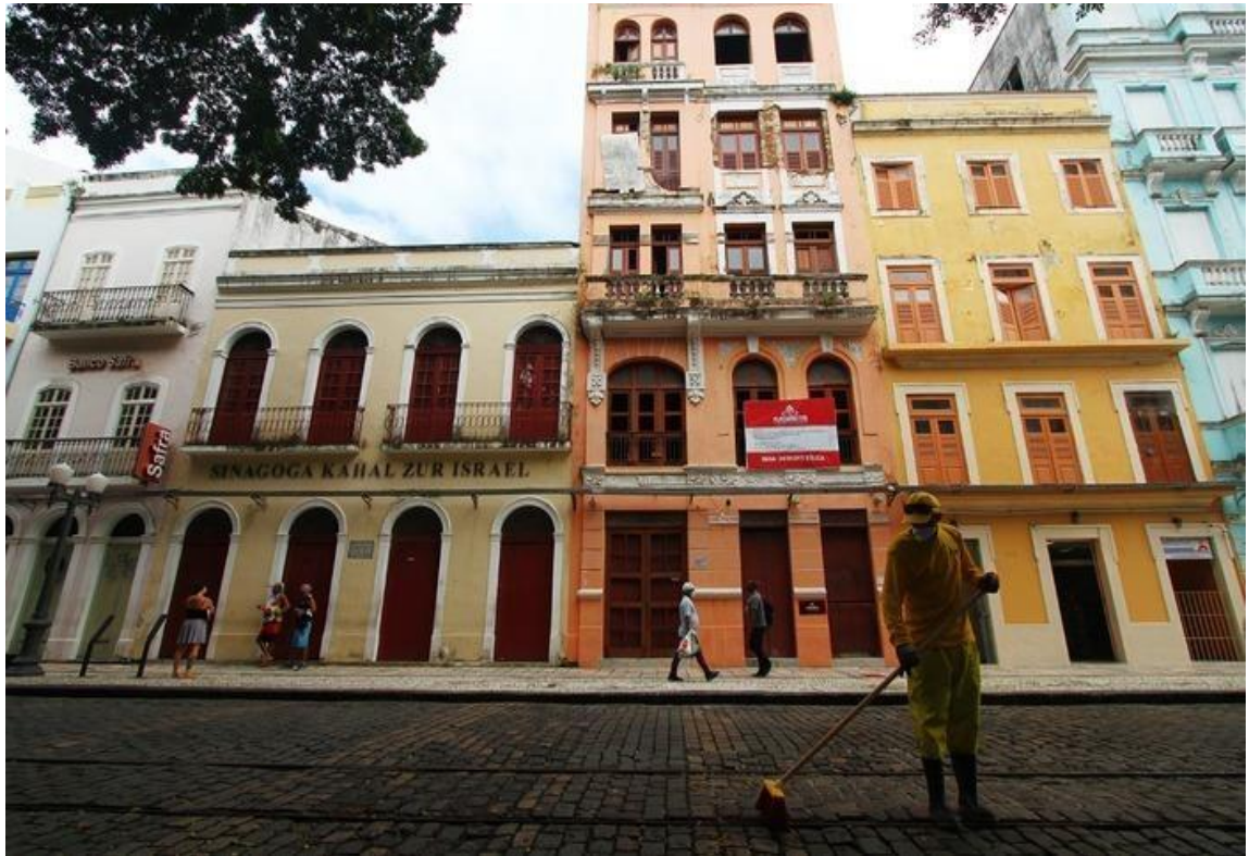
FIGURA 14: Rua do Bom Jesus antes da intervenção.
