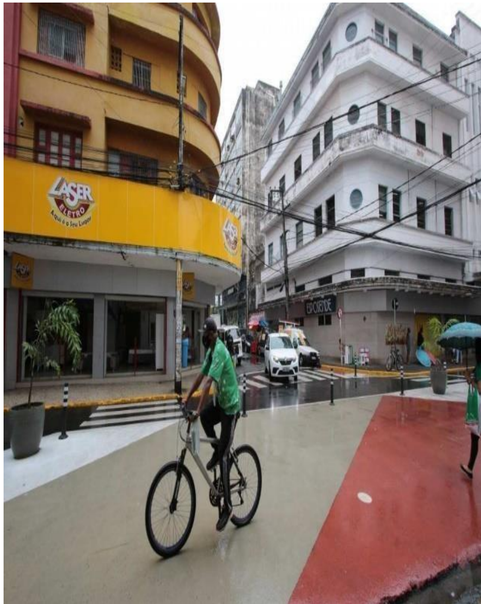
FIGURA 09: Rua da Palma após a intervenção.
