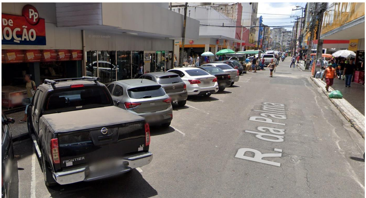
FIGURA 06: Rua da Palma antes da intervenção.
