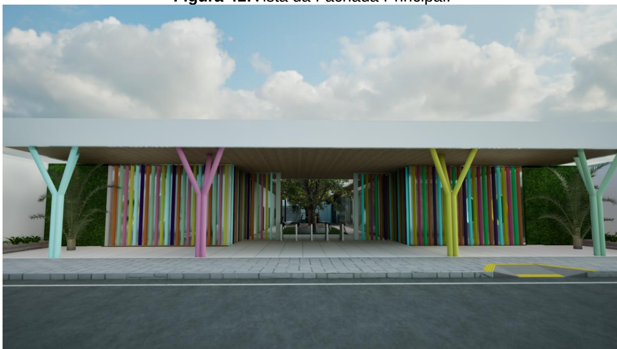
Figura 41: Vista da Fachada Principal.
