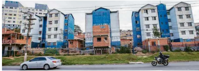
Figura 23 - Construções irregulares dentro do Conjunto Habitacional Barão de Antonina, do Projeto Cingapura, em São Paulo.
