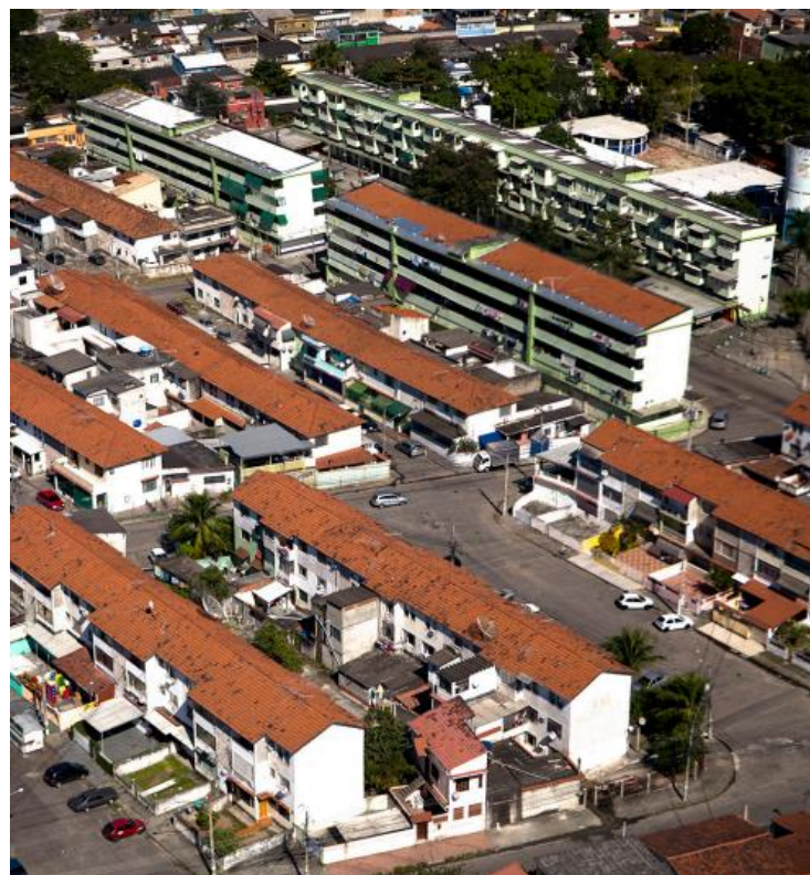
Figura 14 - Conjunto Realengo visto de cima com seus variados tipos de habitações.
