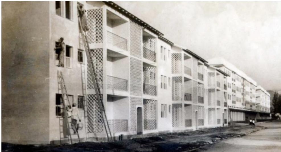
Figura 16 - Edifícios de três andares com dois apartamentos por andar.
