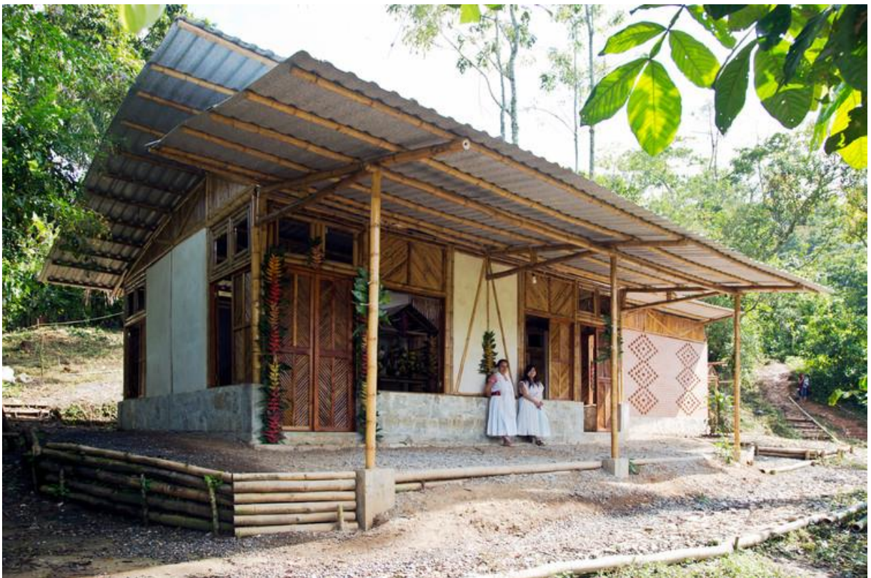
Figura 7 - Casas construídas de bambu em Tepetzintan com ajuda dos próprios habitantes.
