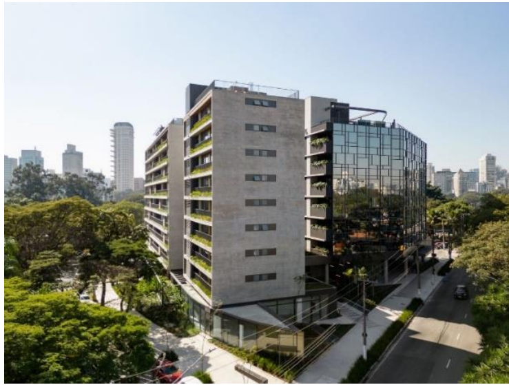
Figura 6 - Fachada do Edifício
