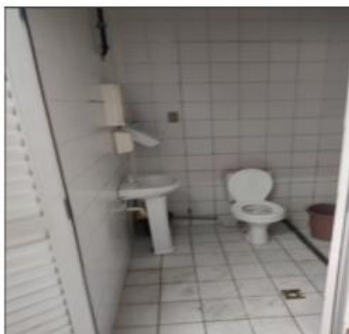
Figura 72 - Banheiro dos deficientes.
