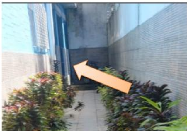
Figura 64 - Entrada para a recepção 2.
