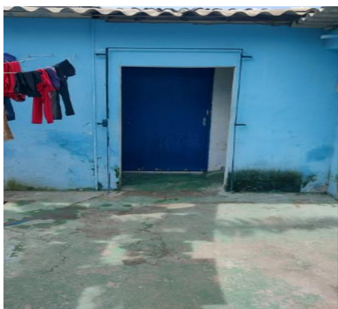
Figura 40 - Banheiro dos usuários.
