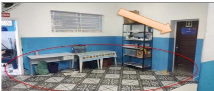
Figura 71 - Acesso ao banheiro feminino.
