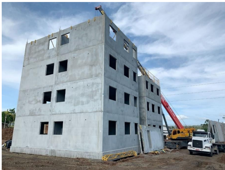
Figura 28 – Construção modular com paredes de concreto
