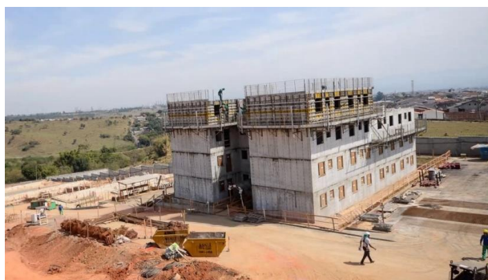
Figura 29 – Canteiro de obras construção com paredes pré-moldadas
