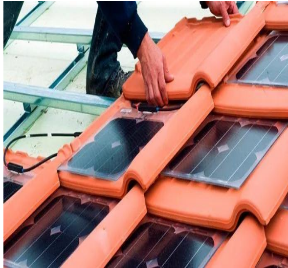
Figura 9: Telha solares fotovoltaicas com placas de silício monocristalino
