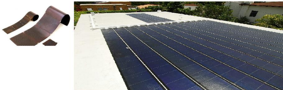
Figura 3: Filme e aplicação da placa em silício de amorfo
