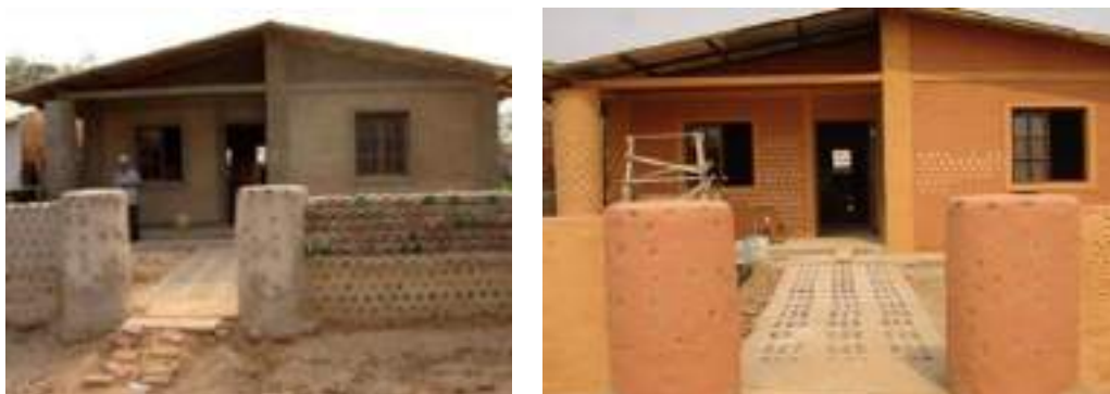
Figura 26: Casa em construção e casa finalizada. (Brasil)
