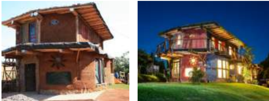
Figura 17: Bioconstrução Guaraciaba, casa de cob (Brasil).
