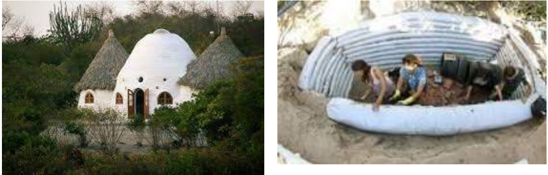
Figura 18: Oca domo de superadobe pronto e em construção (Brasil).
