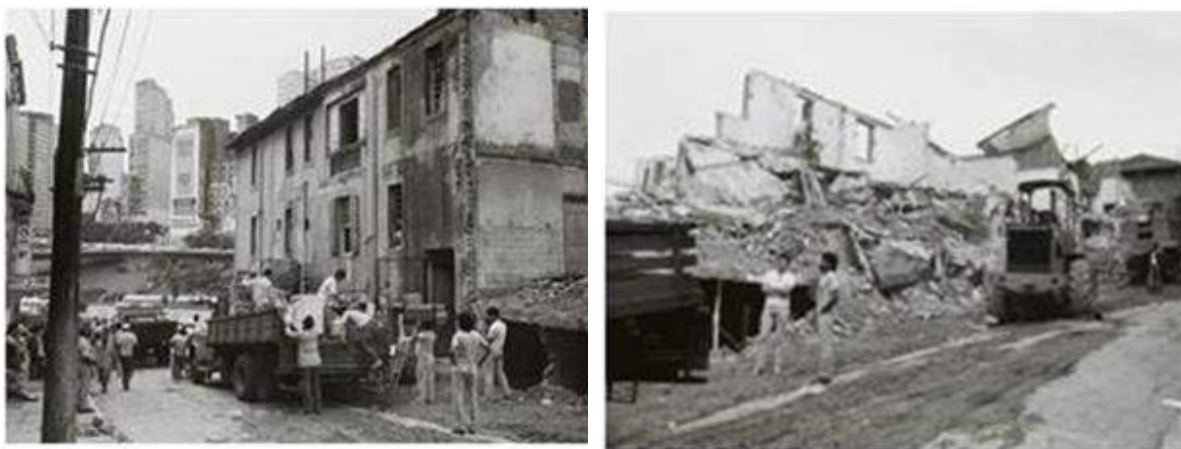
Figura 06: O processo de desocupação e demolição das edificações nas ruas Jandaia e Assembleia.
