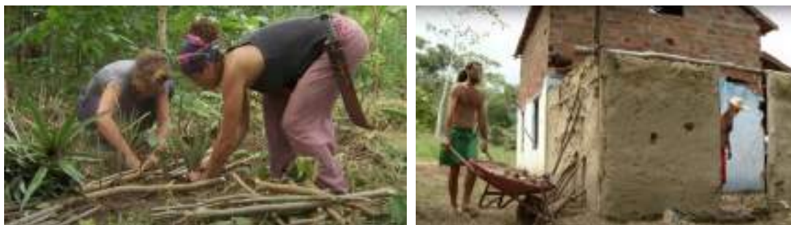
Figura 24: Construção de casas no Kilombo Tenondé.
