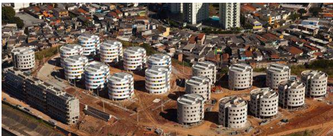
Figura: 28 Foto perspectiva do HIS em obras
