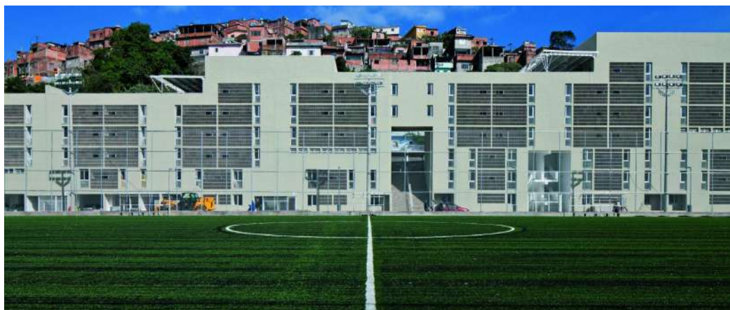
Figura: 25 Vista frontal do conjunto habitacional
