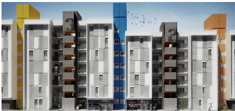
Figura: 17 Vista frontal do conjunto habitacional
